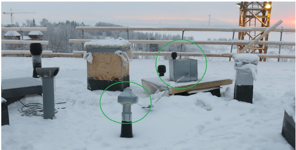
KUVA 20. Kuvassa on työmaa-aikaiset, kosteudenpoistoon tarkoitetut puhaltimet.
