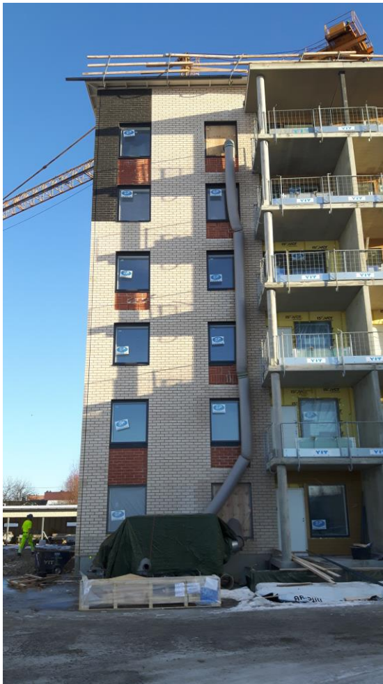
KUVA 16. Vaunukuivaimen sijoitus rakennuksen runkoon nähden.
