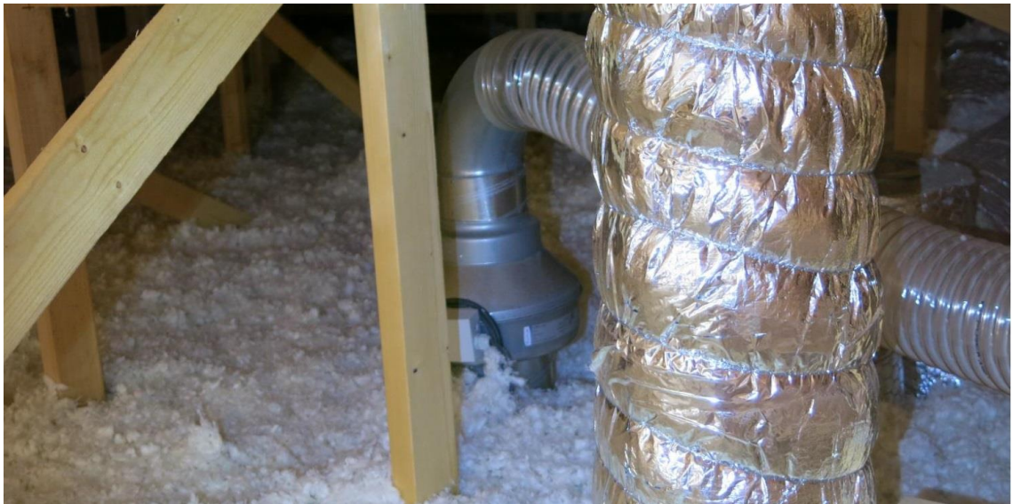
KUVA 19. Kanavapuhallin voidaan sijoittaa myös ullakolle.
