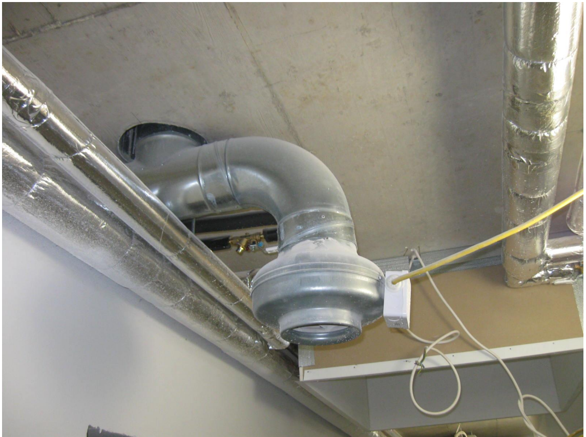
KUVA 18. YIT Rakennus Oy:n työmaalla Rovaniemellä ylimmän kerroksen käytävään on asennettu kanavapuhallin, jonka avulla huolehditaan porrashuoneen kosteudenpoistosta.
