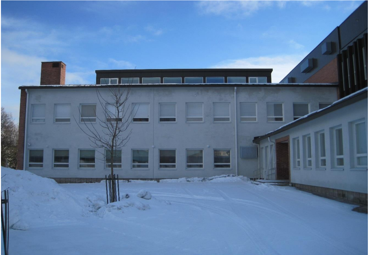
Kuva 10. Julkisivukuva ruokalasta ja voimistelusalista.
