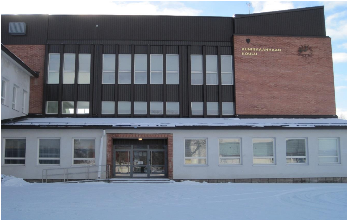
Kuva 3. Kuninkaanhaan koulu korjauksen jälkeen.
