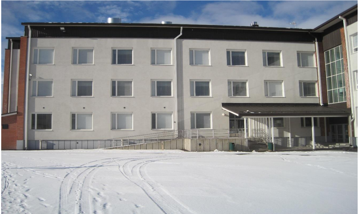
Kuva 4. Julkisivukuva ensimmäisestä vaiheesta.
