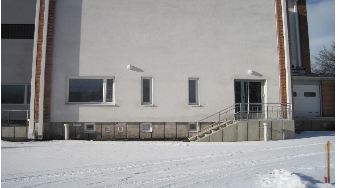
Kuva 8. Julkisivukuva sisäänkäynti varastoon.
