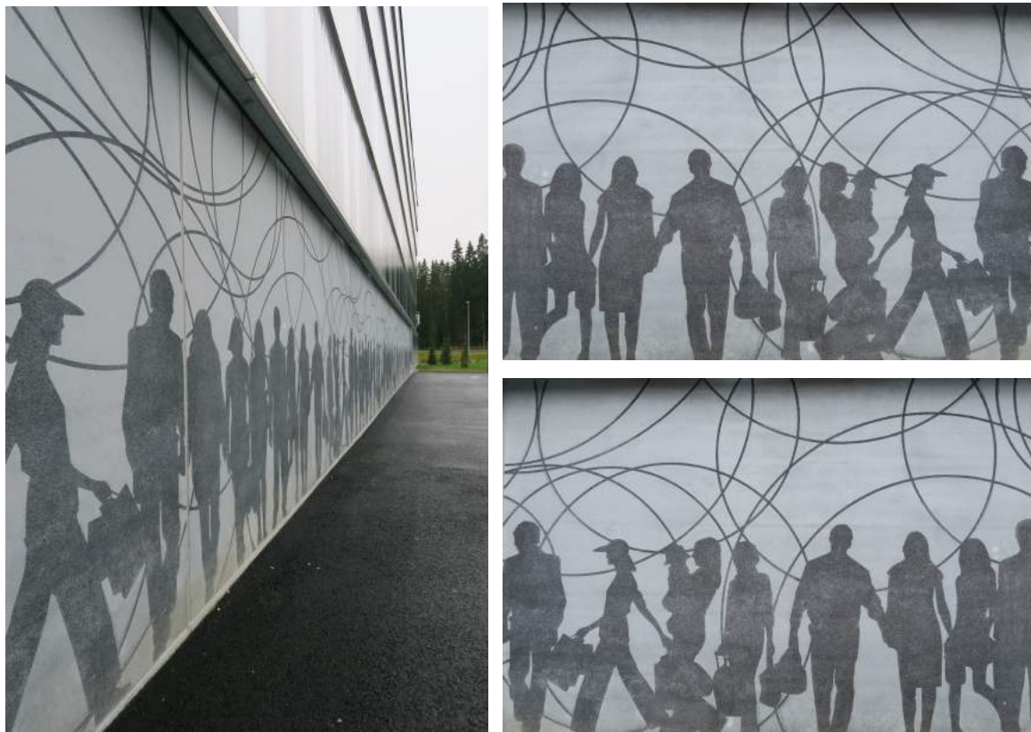
KUVAT 14, 15 ja 16: Kuopiossa sijaitsevan Matkus Shopping Center kauppakeskuksen julkisivussa Betomestarit Oy:n toteuttama graafinen betonipinta. (Sirkkiä 2015.)
