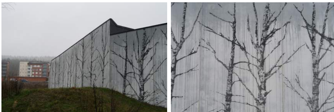
KUVAT 17 ja 18: Meluaita graafisesta betonista Betonimestarit Oy:n toteuttamana. Kuvat otettu satteella, joten pinnassa valumajälkiä sadevedestä. (Sirkkiä 2015.)
