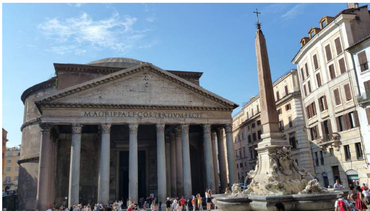
KUVA 10: Noin 2000 vuotta vanha Rooman Pantheon on ensimmäisimpiä ja tunnetuimpia rakennuksia, jossa on käytetty betonirakenteita. (Pixabay 2016.)
