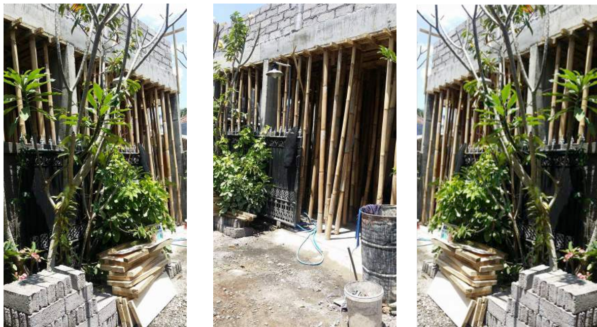
KUVAT 11,12 ja 13: Betoniharkkojen ladonta kaksikerroksiseen asuinrakennukseen. (Paryana 2015.)
