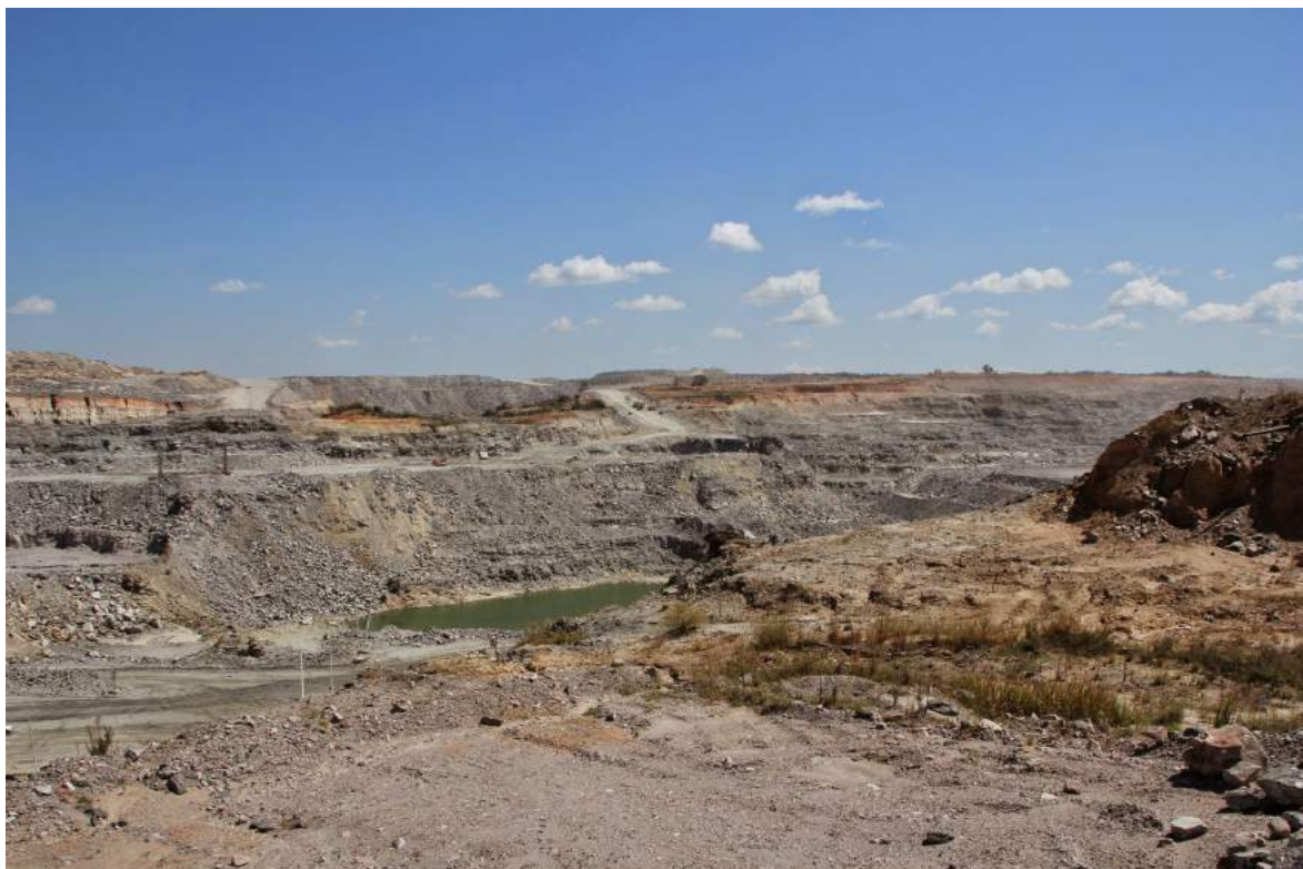
KUVA 3: Lumwanan rakenteilla oleva kaivosalue. (Wuorisalo 2013.)
