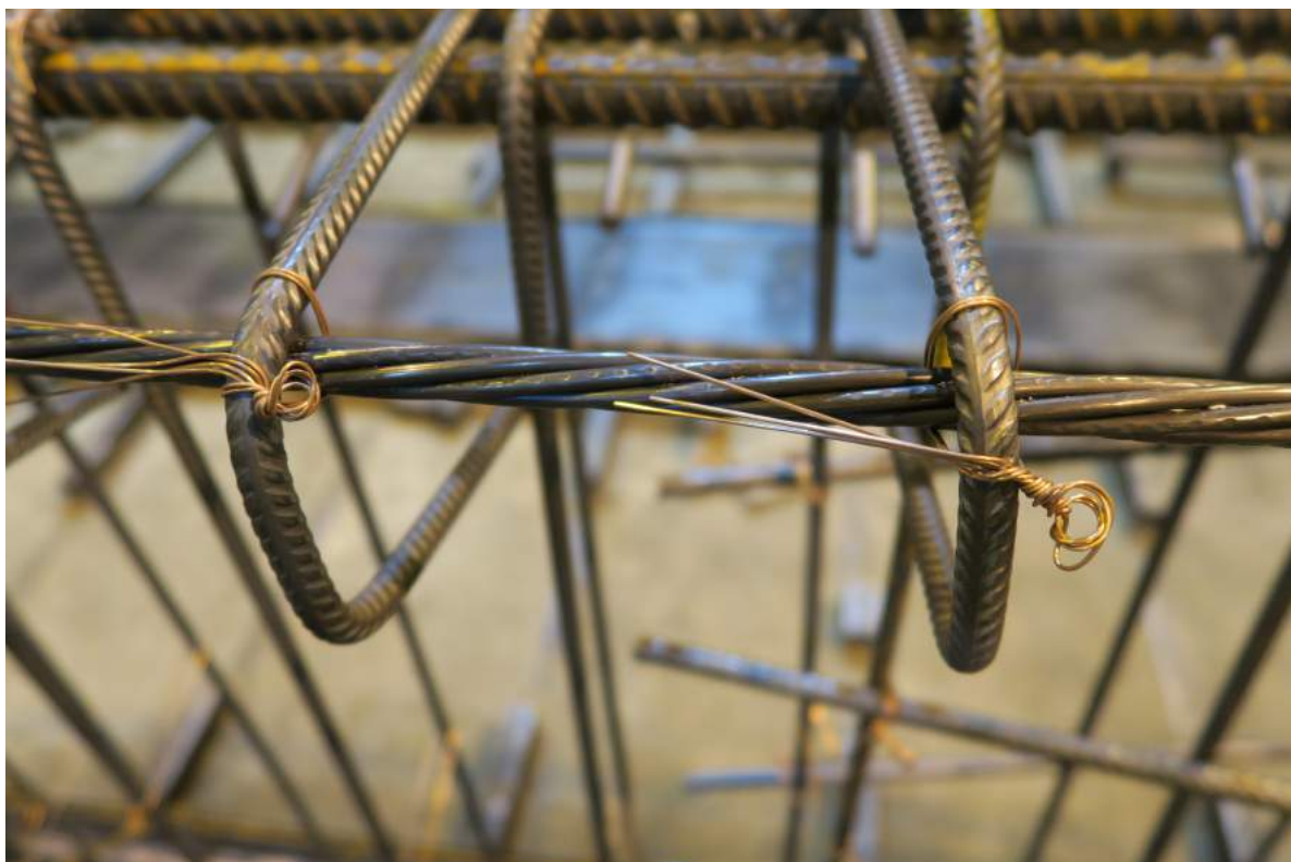
KUVA 7: Raudoitus betonielementin valua varten. (Sirkkiä 2015.)
