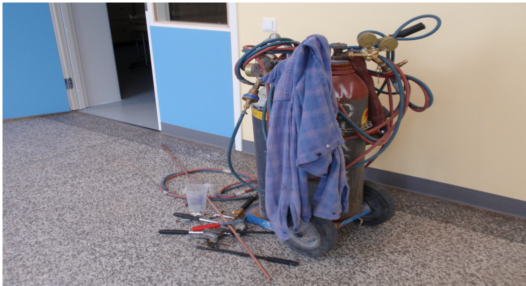
KUVA 6. Koulun ja esikoulun välisellä käytävällä oli loppusiivouksen jälkeen hitsauslaitteet.
