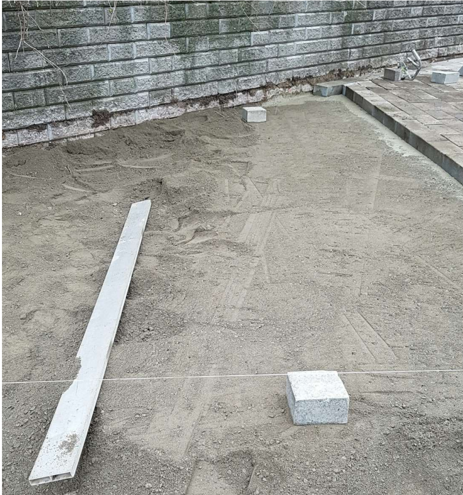
Kuva 7. Levitetty ja tasattu asennuspohja maakosteasta betonista
