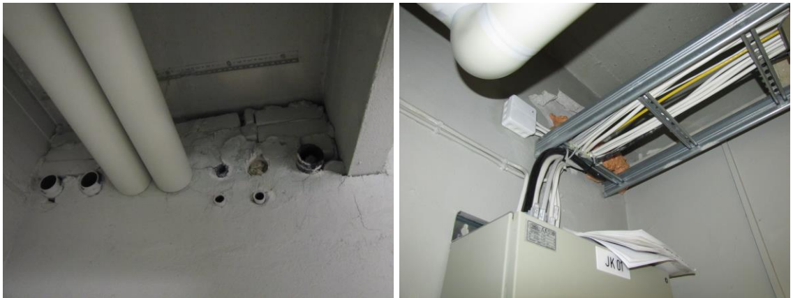
Kuva 121 ja Kuva 122. LJH 024 huoneen seinät
