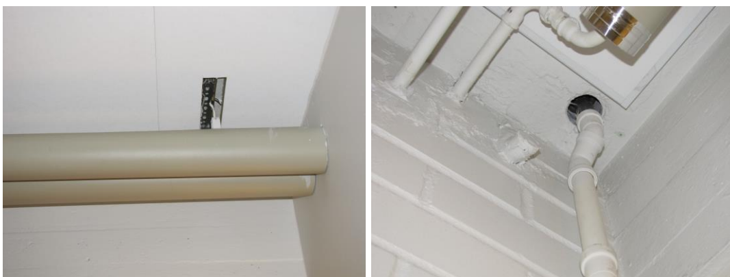
Kuva 58 ja Kuva 59. Läpiviennit ja kiinnikkeet
