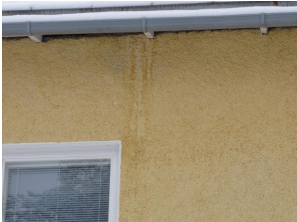
Kuva 26. Vesivuodon jälki
