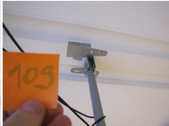
Kuva 41. Projektorin asennus teipillä
