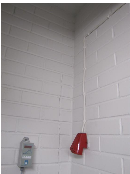
Kuva 68 ja Kuva 69. Halkeamat seinissä
