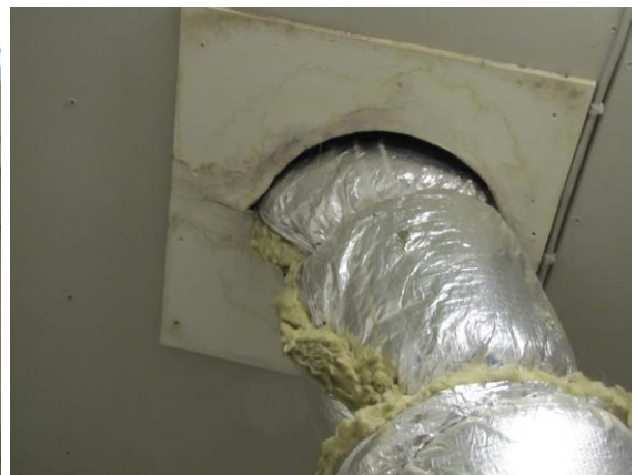
Kuva 124. Vesivuodon jälki (036)
