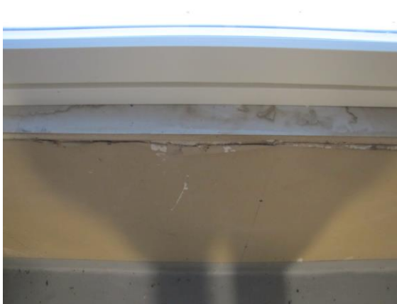
Kuva 123. Vesivuodon jälki (301)
