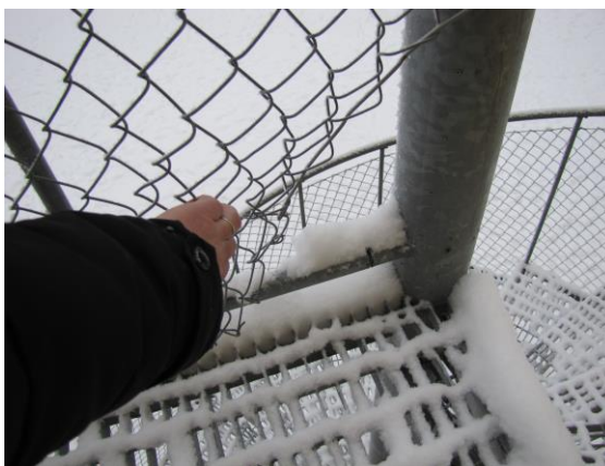
Kuva 5 ja Kuva 6. Teräsverkko irti rungosta
