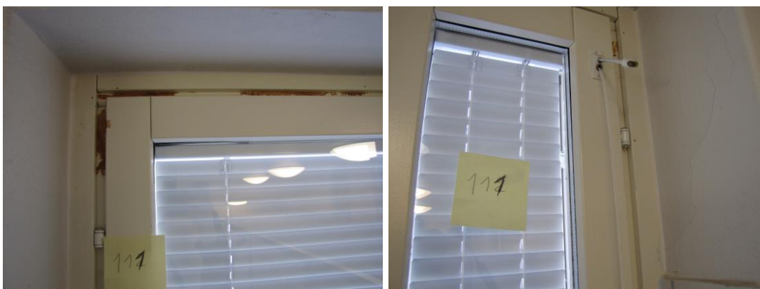
Kuva 107 ja Kuva 108. WC:n 111 ikkuna
