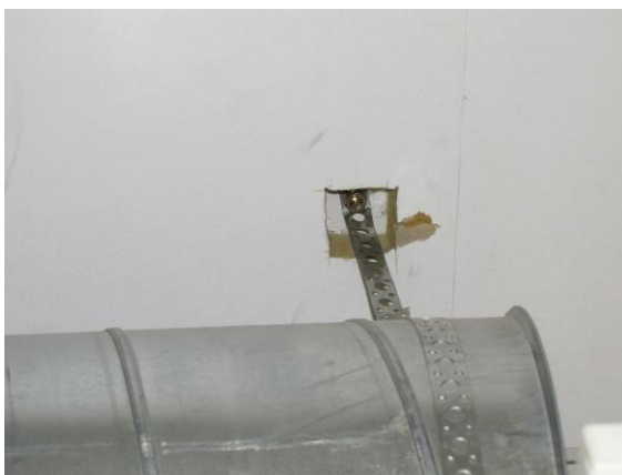
Kuva 32. Kiinnikkeet akustolevyssä
