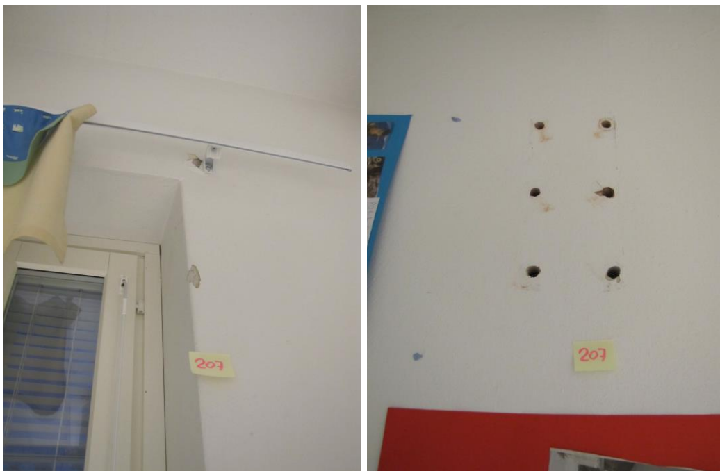
Kuva 50 ja Kuva 51. Luokkien seinät
