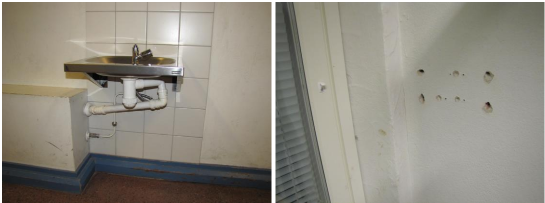
Kuva 92 ja Kuva 93. Käytävän 202 seinät
