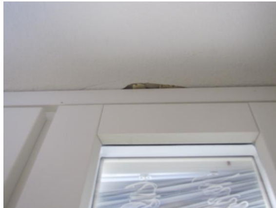
Kuva 75. Ikkunan asennusjälki (117)
