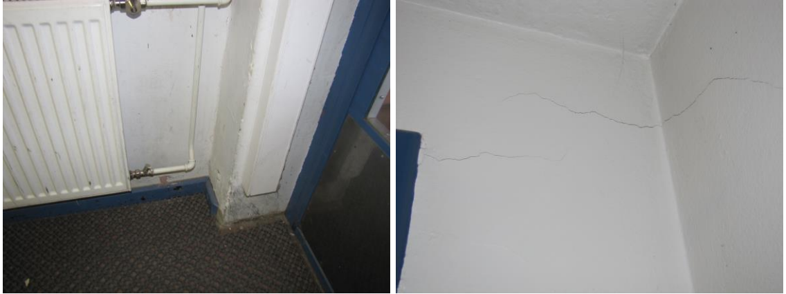
Kuva 90 ja Kuva 91. Porrashuoneen seinät
