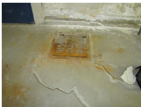
Kuvat 132...137. Tila K02, kosteudesta johtuvia jälkiä
