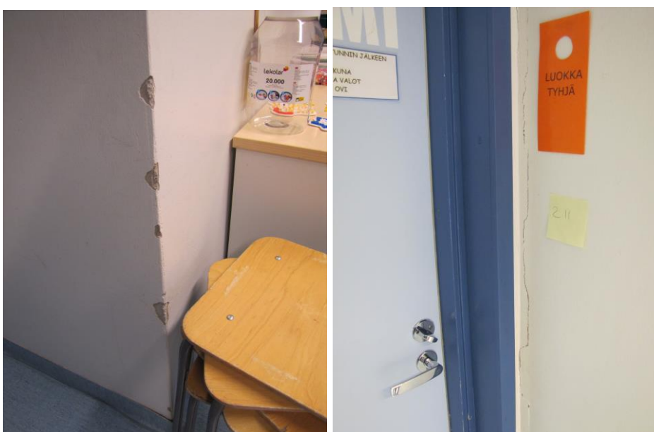
Kuva 48 ja Kuva 49. Luokkien seinät
