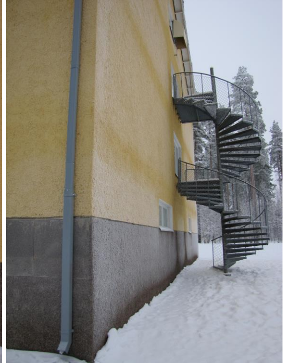
Kuva 8. Esteetön pääsy portaisiin
