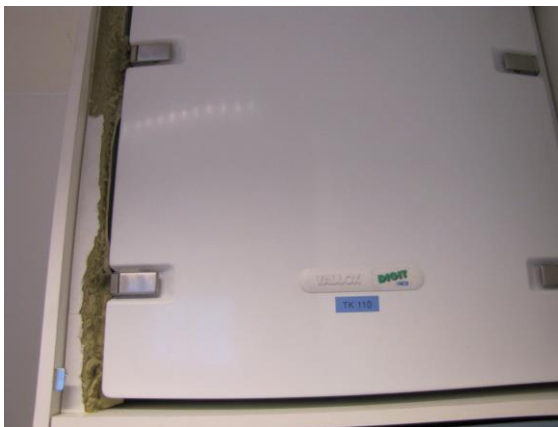
Kuva 42 ja Kuva 43. Peittämätön mineraalivilla
