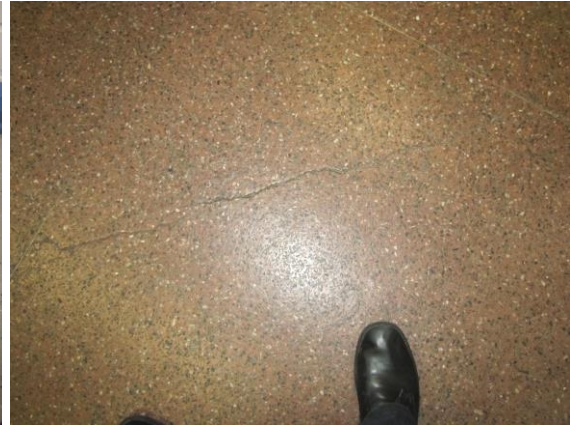
Kuva 87. Vanhat halkeamat
