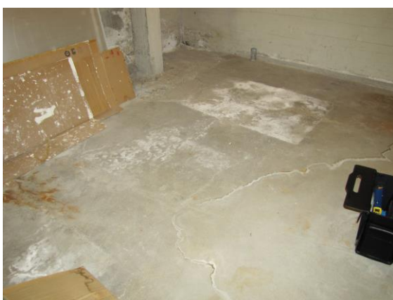
Kuvat 132...137. Tila K02, kosteudesta johtuvia jälkiä
