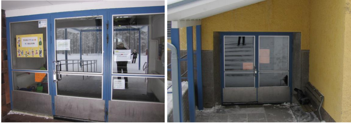
Kuva 15 ja Kuva 16. Ulko-ovet
