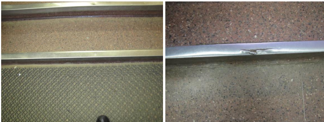
Kuva 97 ja Kuva 98. Portaiden teräskulmat
