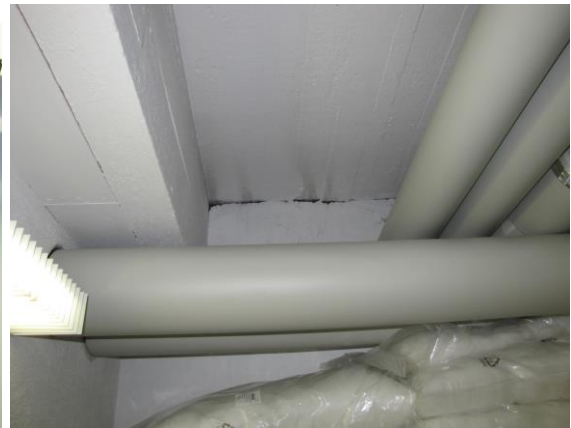
Kuva 112. Seinän ja katon liitos (025)
