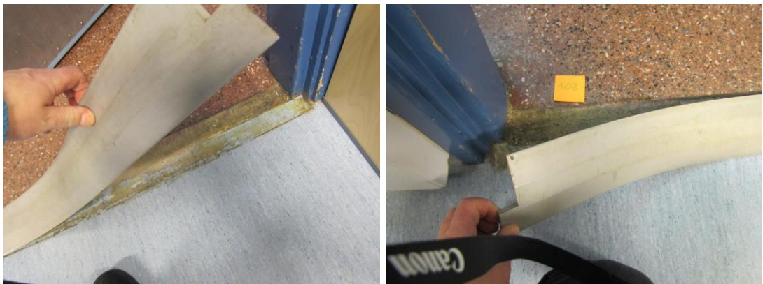
Kuva 38 ja Kuva 39. Ovikynnykset irti, lk 108 ja 110
