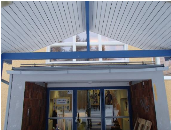
Kuva 24. Katoksen räystäskouru
