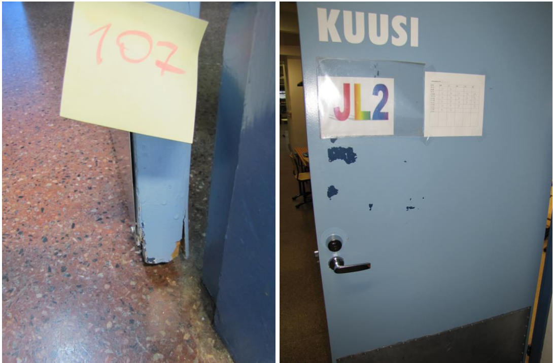
Kuva 36 ja Kuva 37. Luokkien ovet
