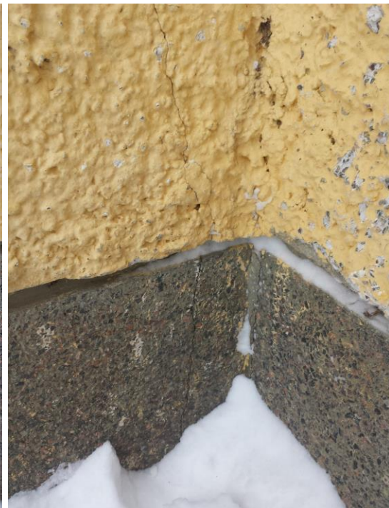
Kuva 2. Halkeamat sokkelissa
