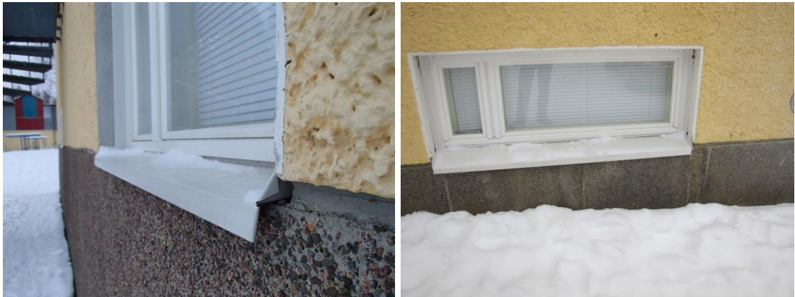
Kuva 13 ja Kuva 14. Ikkunoiden pellitykset
