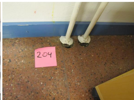
Kuva 45. Putkien läpiviennit
