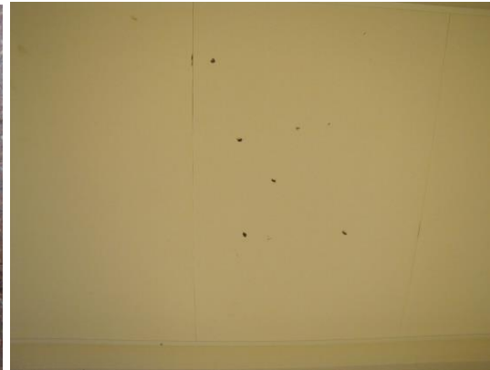
Kuva 29. Reiät akustolevyissä, lk 106
