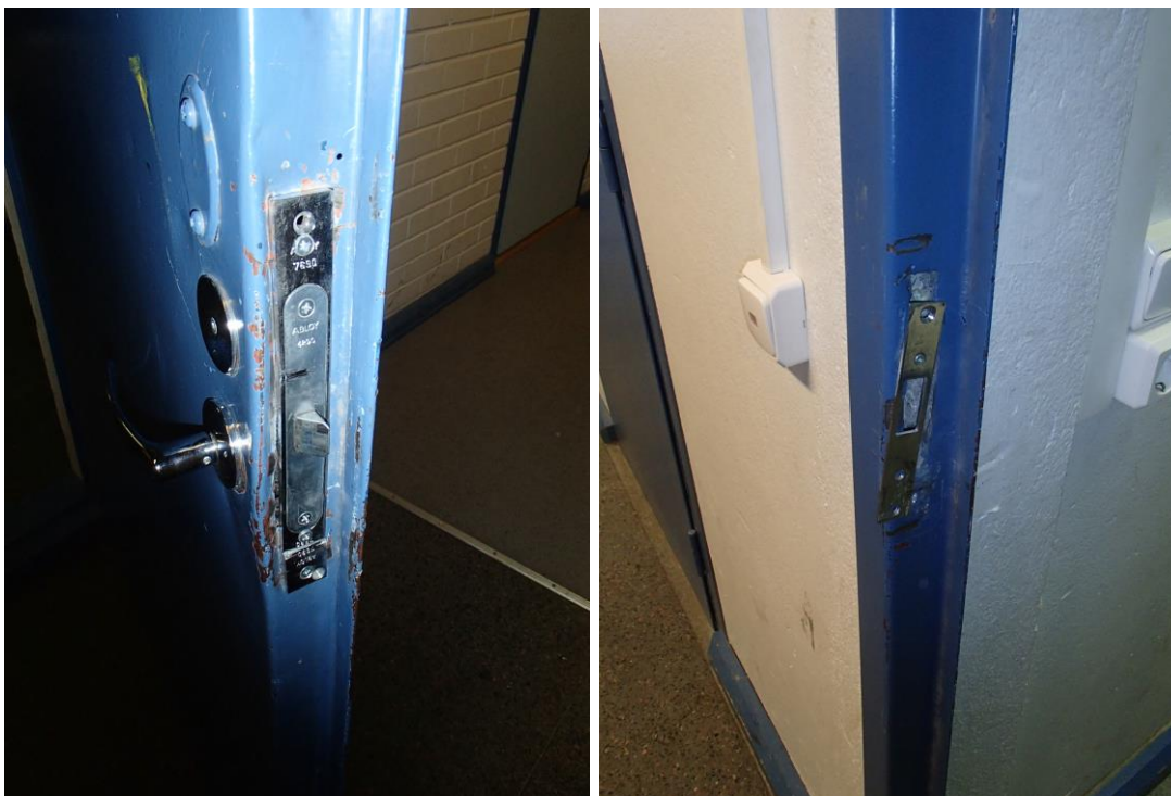
Kuva 96. Käytävän 002 ja käytävän 003 välinen ovi
