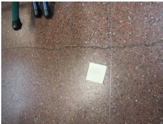
Kuva 28. Vanhat halkeamat
