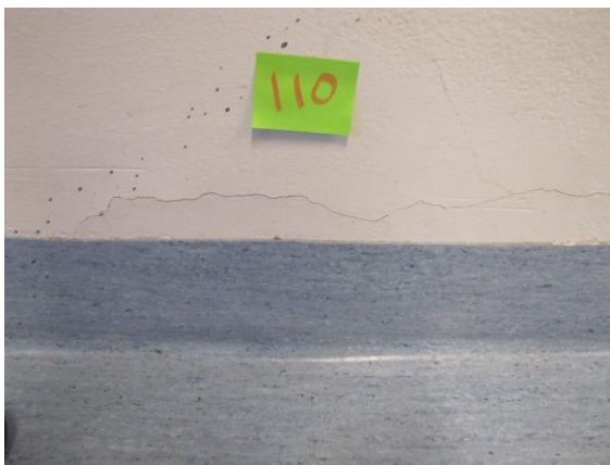
Kuva 34 ja Kuva 35. Halkeamat seinissä
