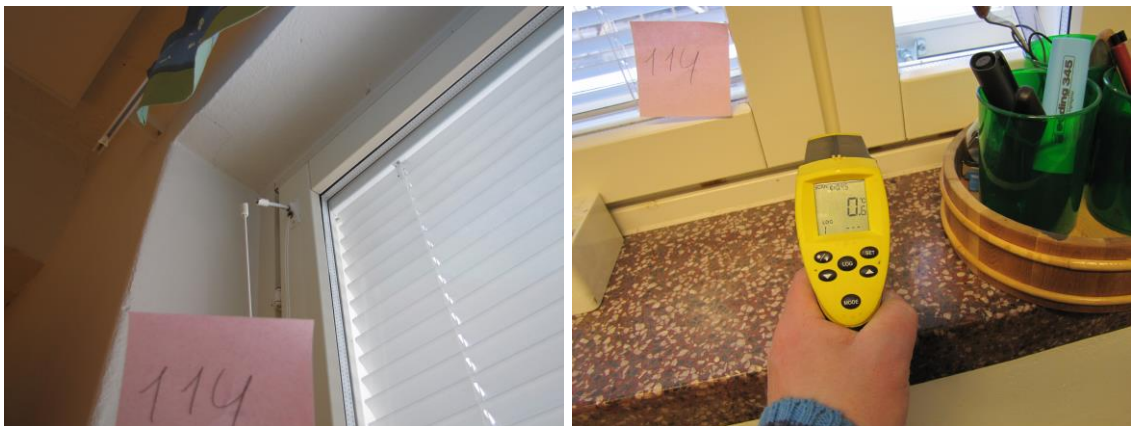
Kuva 72 ja Kuva 73. Huoneen 114 ikkuna
