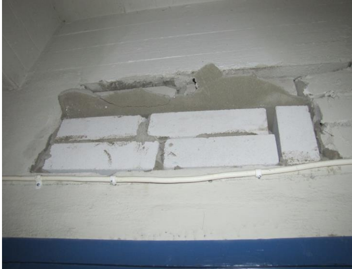
Kuva 129. Muurauslaasti oven yllä (016)
