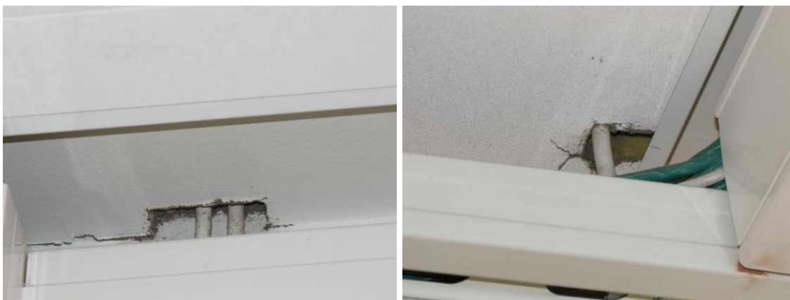
Kuva 46 ja Kuva 47. Sähköjohtojen läpiviennit, lk 211
