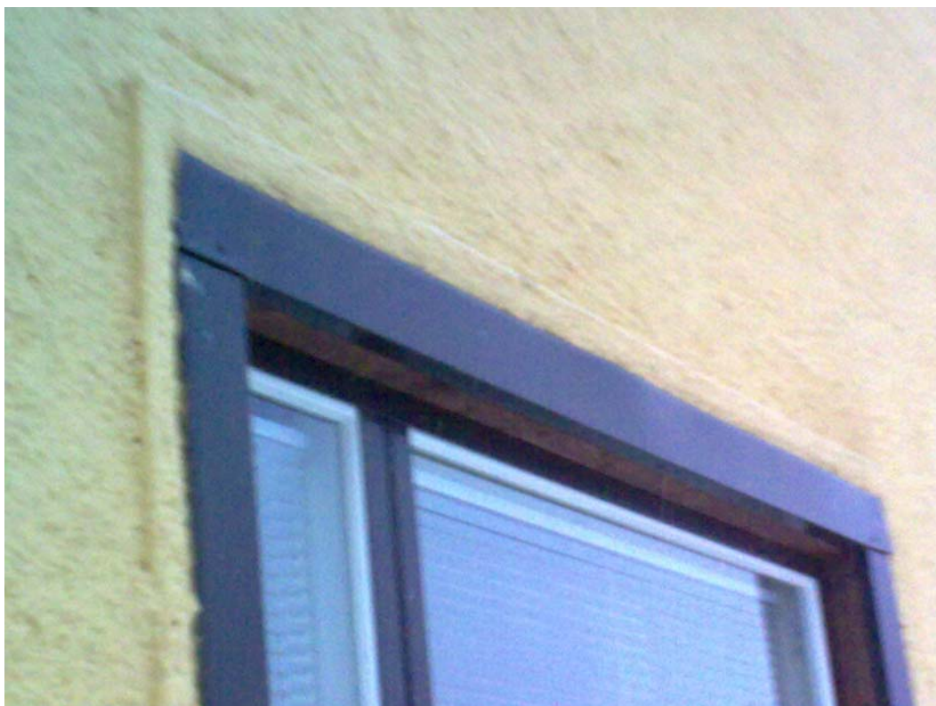
Kuva 2, Ikkunan pieli korjauksen jälkeen
