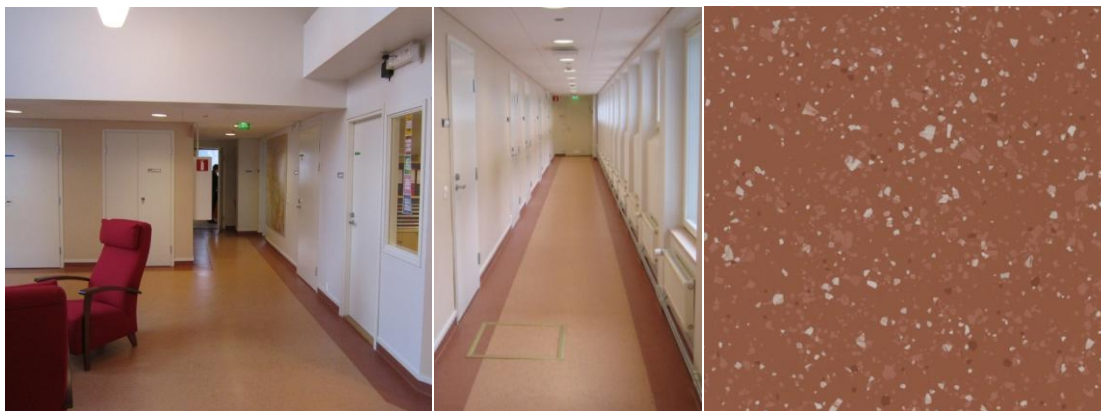
Kuva 5. Aulatilojen vanha muovimatto ja uusi laattaväri.
