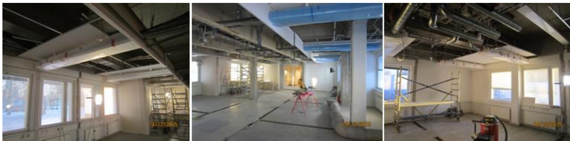
Kuva 4. Päätelaitteiden alla säilytettävä alakattolevytytys.
