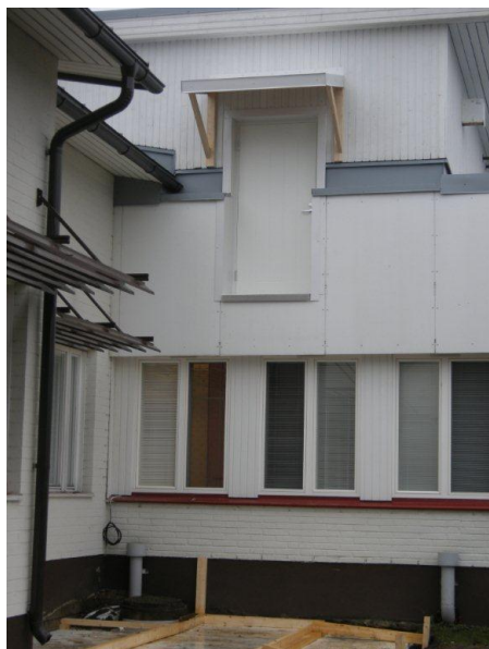
Kuva 8. IV-konehuoneen uusi ulko-ovi.
