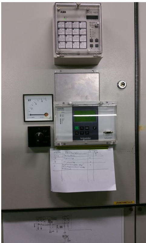
Kuva 16 Uusi rele asennettuna (Kuva: Niko-Ville Ylioja)
