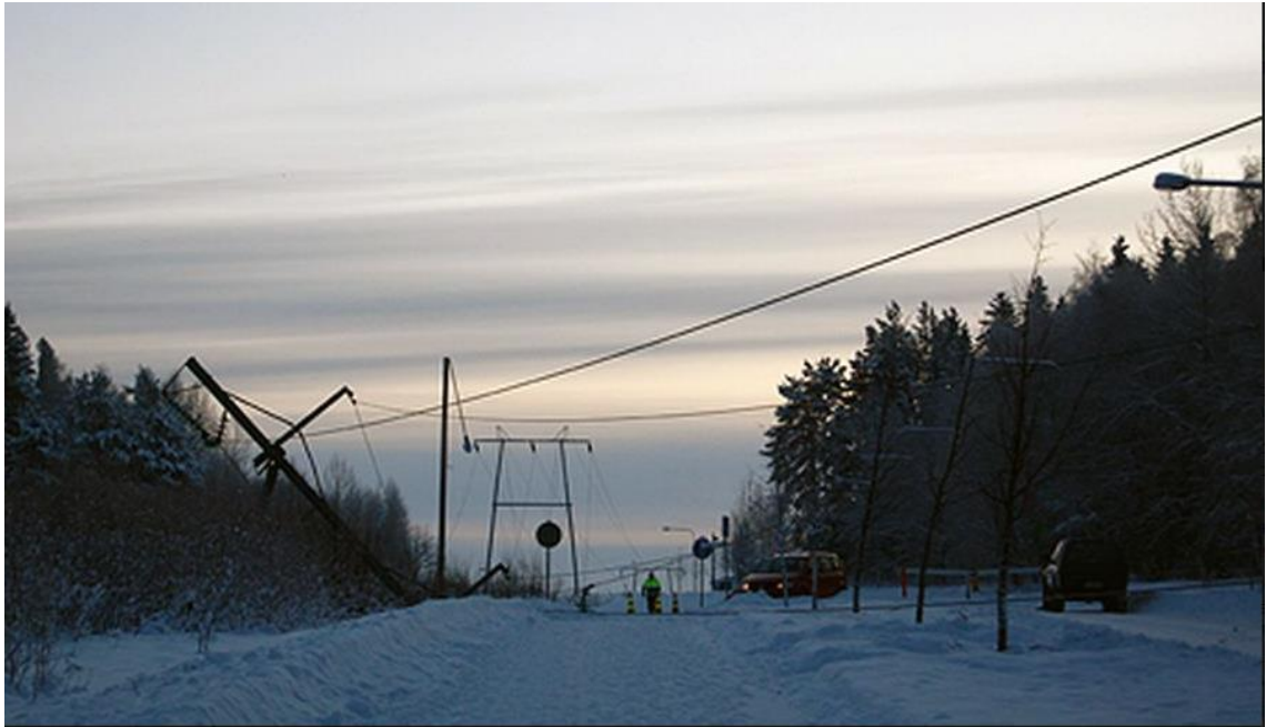
Kuva 7. Katkennut johdinpylväs Ikaalisissa (Kuva. Leppäkosken Sähkö)
