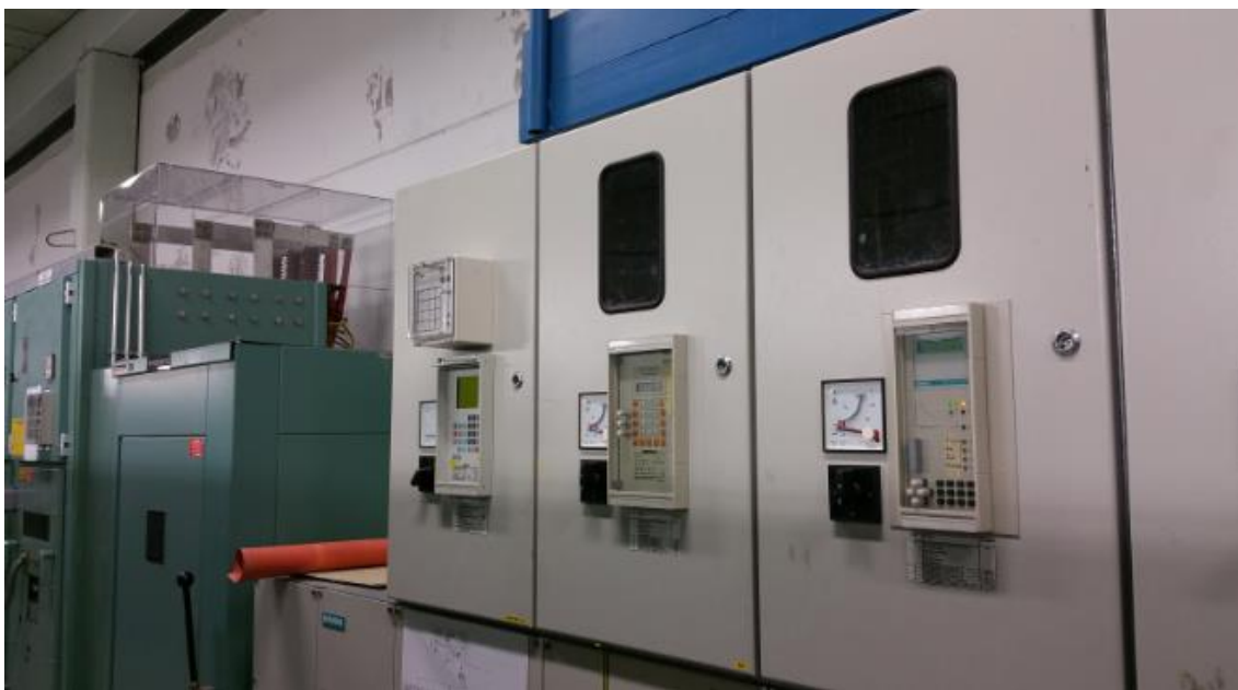
Kuva 14 Releen vaihto tehtiin vasemmanpuoleisimpaan kennoon (Kuva: Niko-Ville Ylioja)
