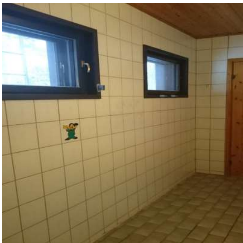
Kuva 1. Kylpyhuoneessa on kaksi ikkunaa.
