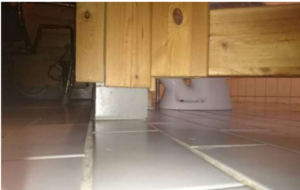
Kuva 11. Saunan ja kylpyhuoneen välinen seinä. Seinän alaohjauspuu lähtee betonilattian tasolta.
