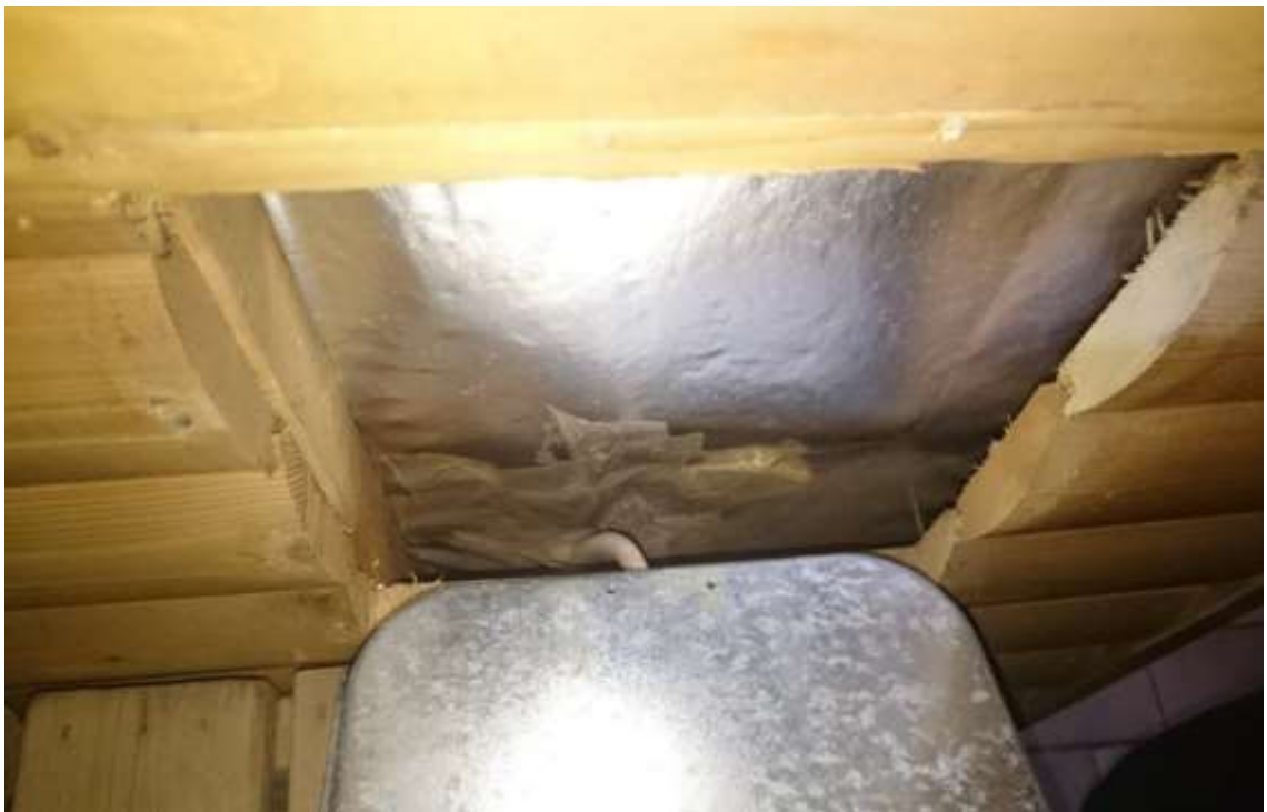
Kuva 12. Alumiinipaperi on asennettu paneloinnin taakse ja tuuletusväli on riittävä.
