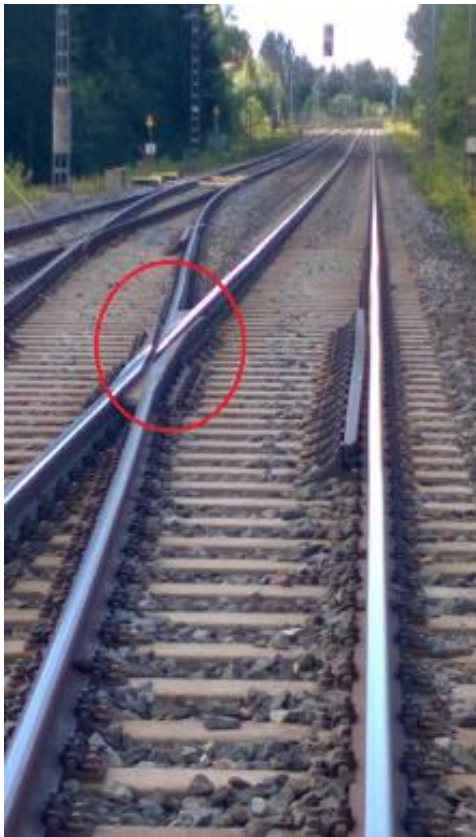
Kuva 14. Vaihteen ristikko. (Kuva: Jani Hietanen)
