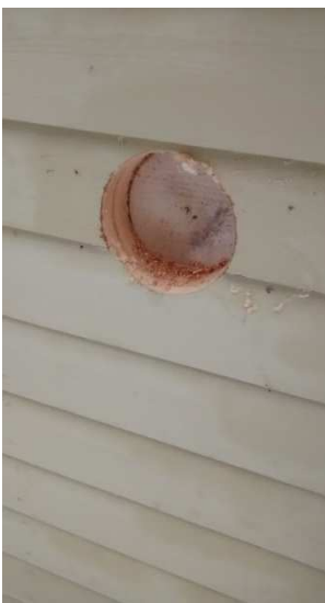
KUVA 7. Seinärakenteen selvittämiseksi porattiin kooreikä
