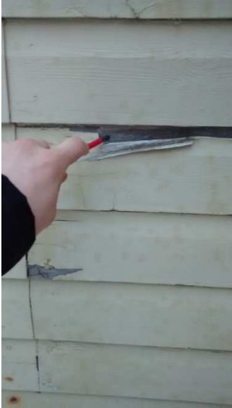
KUVA 2. Maalipinta irtoaa isoina liuskeina
