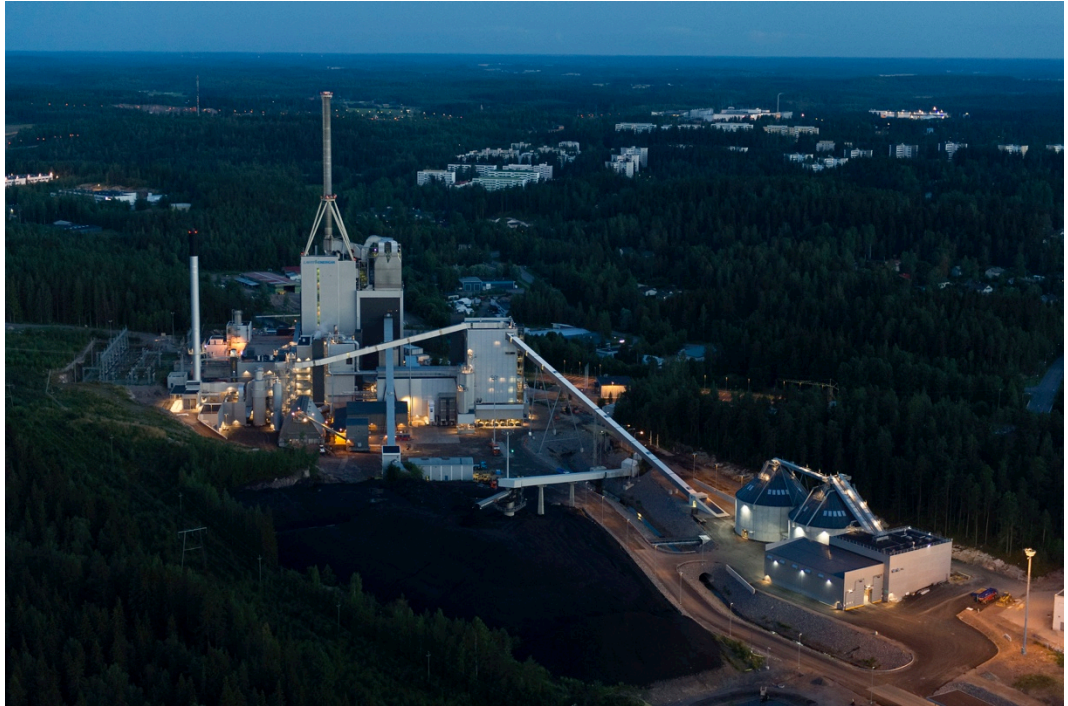
KUVA 1. Kymijärven voimalaitos (International District Energy Association 2012)
