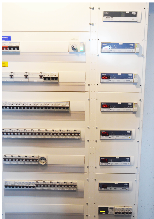
Figur 15. En elcentral med en router 905, sex stycken dimmerenheter 454 och en reläenhet 494, i höger kant.
