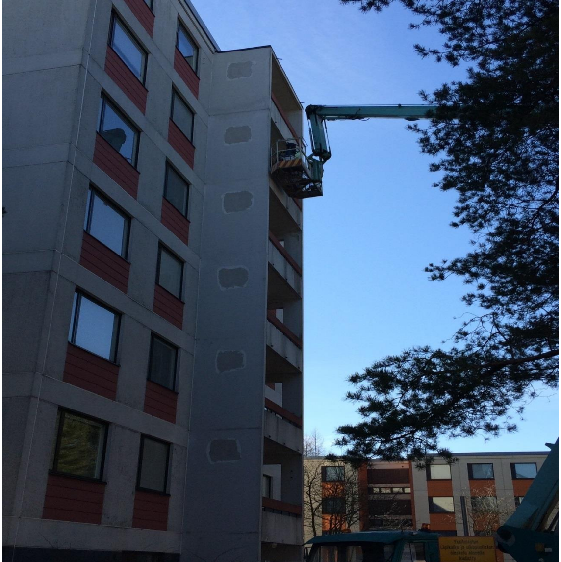
Kuva 2. Asbestin kohdepoisto käynnissä.
