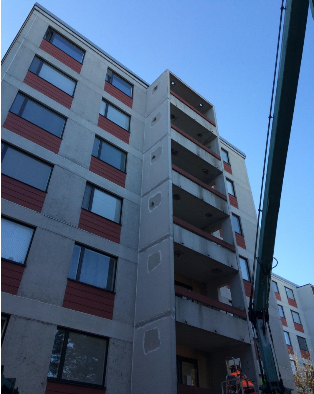
Kuva 5. Nosturin kiinnikereivät asennettuina elementteihin.
