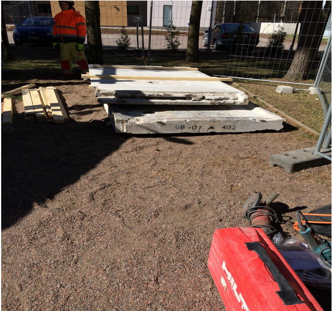
Kuva 4. Purettujen elementtien varastointi.
