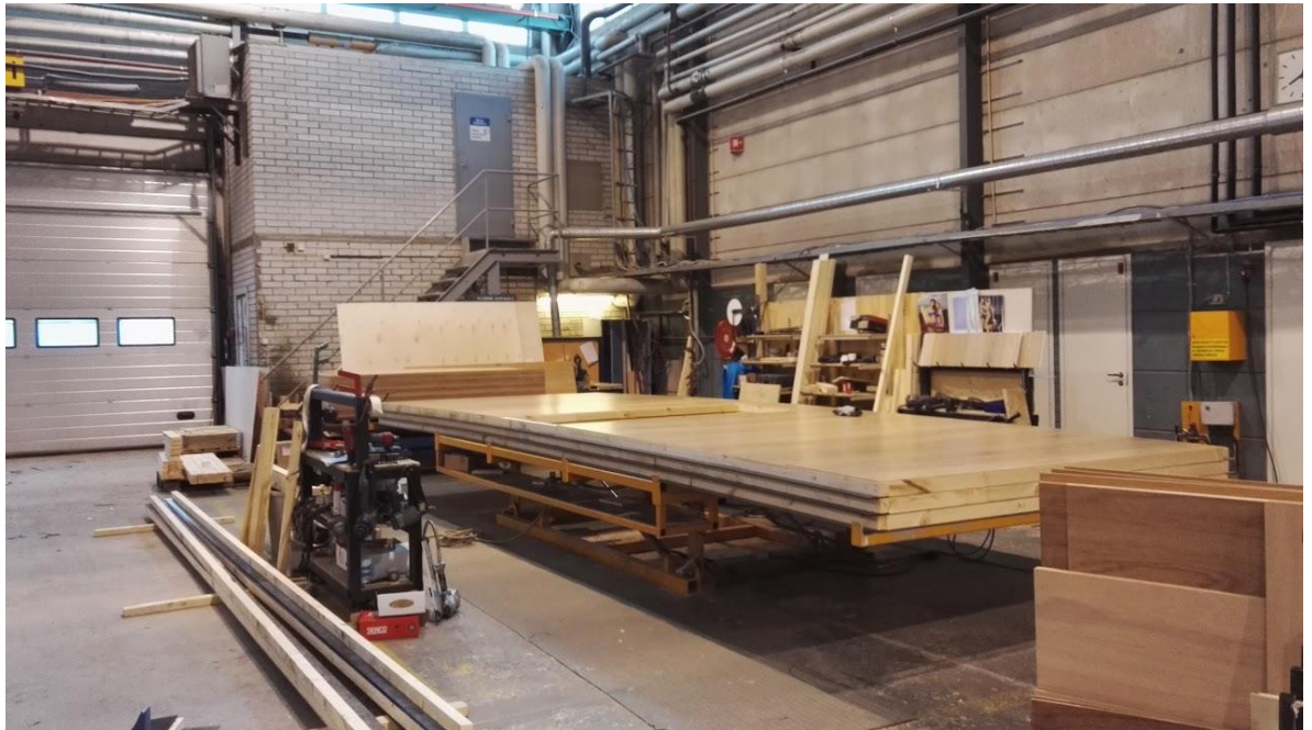
Kuva 4. Työmaatilojen seinäelementtien rakennus piste (Ruuskanen 2016.)
