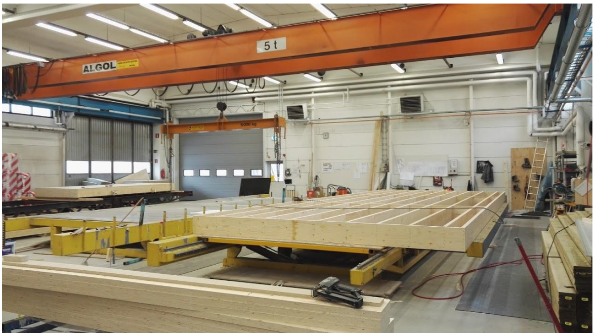
Kuva 8. Lattiaelementin valmistus (Ruuskanen 2016.)
