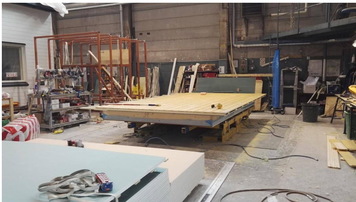
Kuva 6. Ulkoseinäelementtien valmistuspiste (Ruuskanen 2016.)
