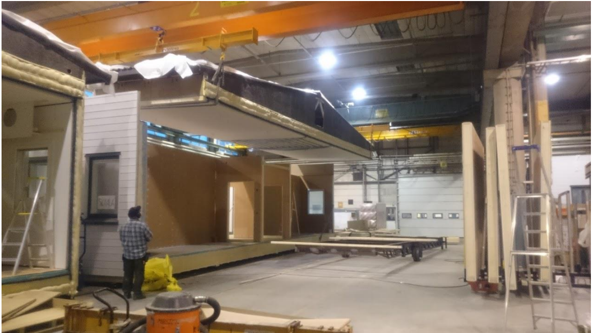
Kuva 10. Kattoelementin nosto (Ruuskanen 2016.)
