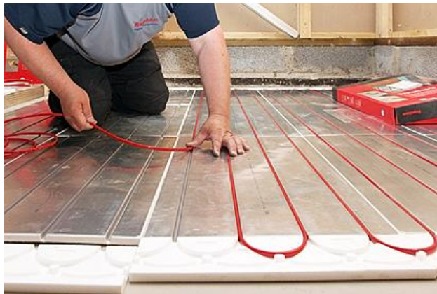
Kuva 8. Energiatehokas koti. Lattialämmityskaapelin asennusta lämmönjakolamelliin, puurakenteiselle lattianalusrakenteelle. Viitattu 12.2.2016. Saatavissa: http://www.energiatehokaskoti.fi/suunnittelu/talotekniikan_suunnittelu/lammitys/sahkolammitys .
