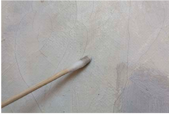
Kuva 31. Maalauksen pinnasta irtosi tummaa pintalikkaa.
