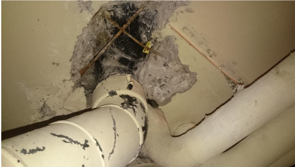
Kuva 17. CD-talon ulkovälinevaraston katto.
