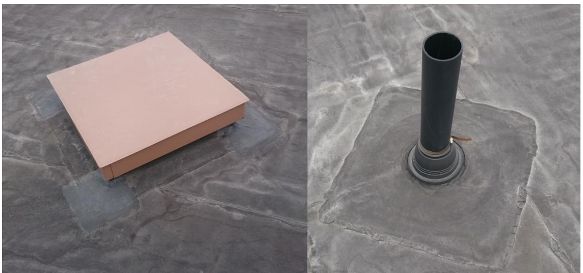
Kuva 13. Huoltoluukun kulmasauman paikkaukset ja viemärin tuuletusputken paikkaus
