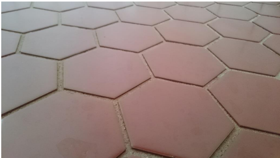
Kuva 15. Lähikuva pesuhuoneen lattialaatoista
