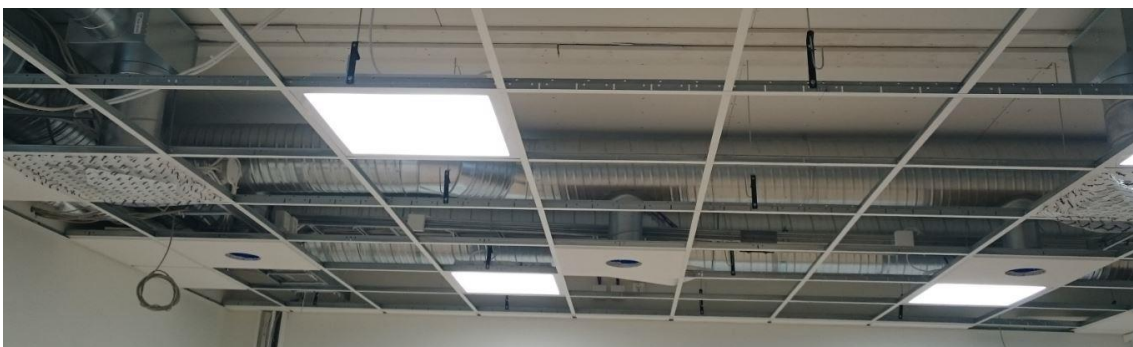
KUVA 8. Tekniikkalevyt ja valaisimet paikoillaan
