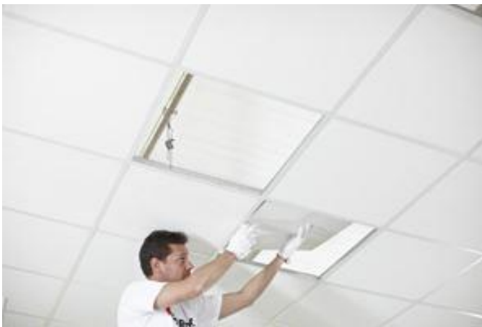
KUVA 10. Levyjen laitto paikoilleen
