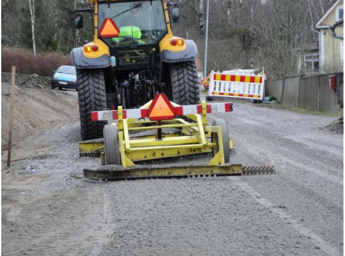
Kuva 2. Sorakadun pinnan tasoittamista tielanalla.
