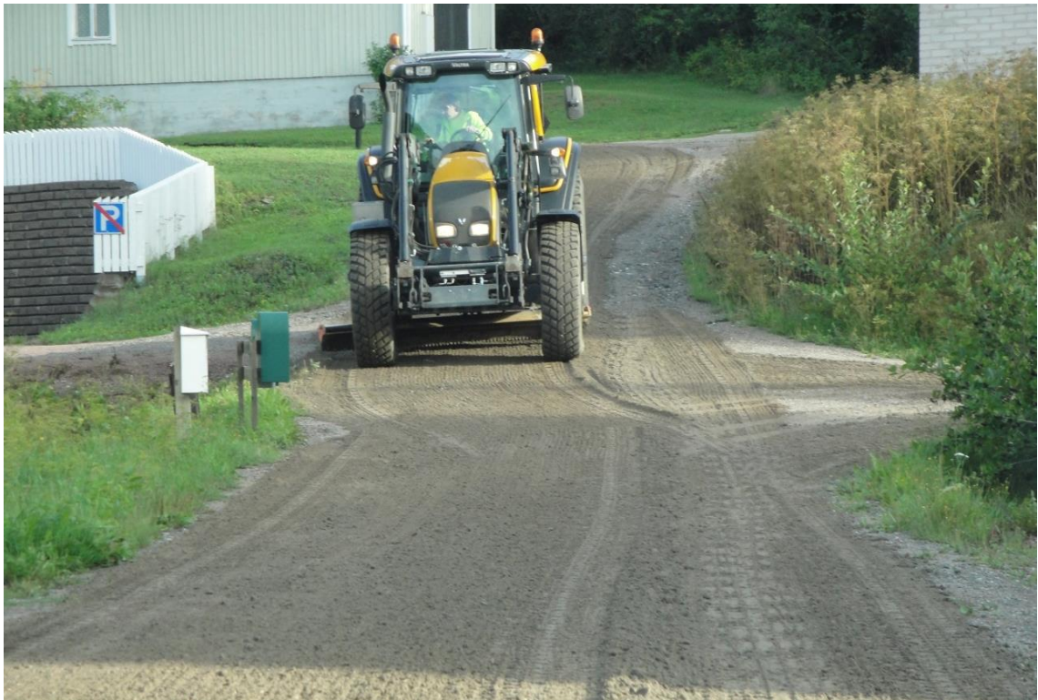
Kuva 1. Sorakadun pinnan tasoittaminen traktorin alaterällä.
