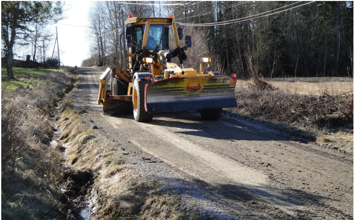
Kuva 3. Östernäsintien soratiepinnan tasoitus tiehöylällä.
