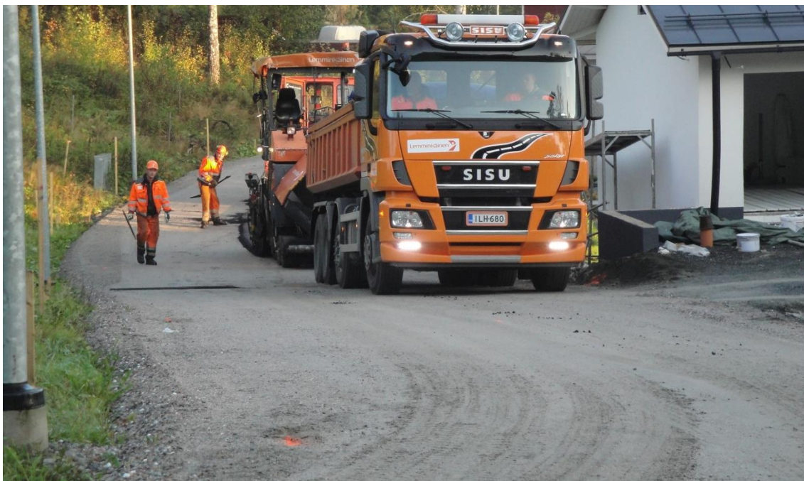
Kuva 4. Kadun asfaltointityöt ovat käynnissä.
