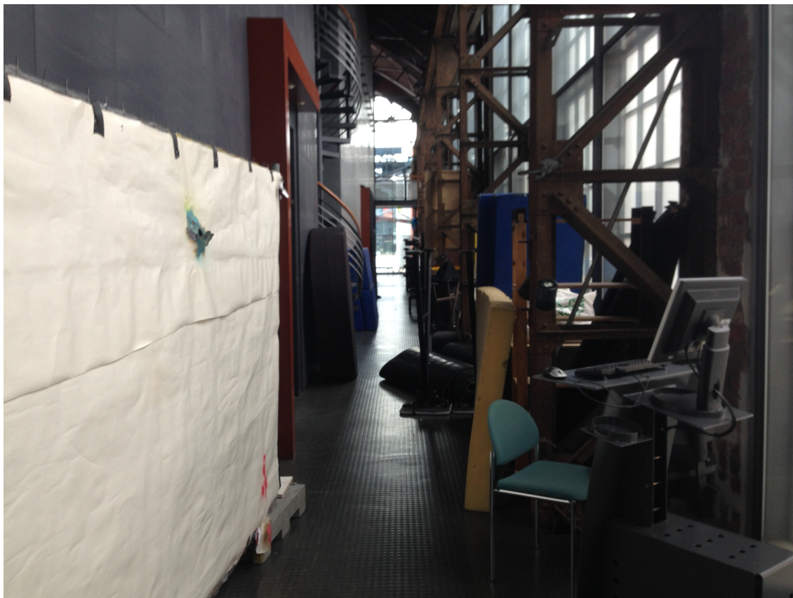
Kuva 12. Tämä poistumistie on kovasti kaventunut.
