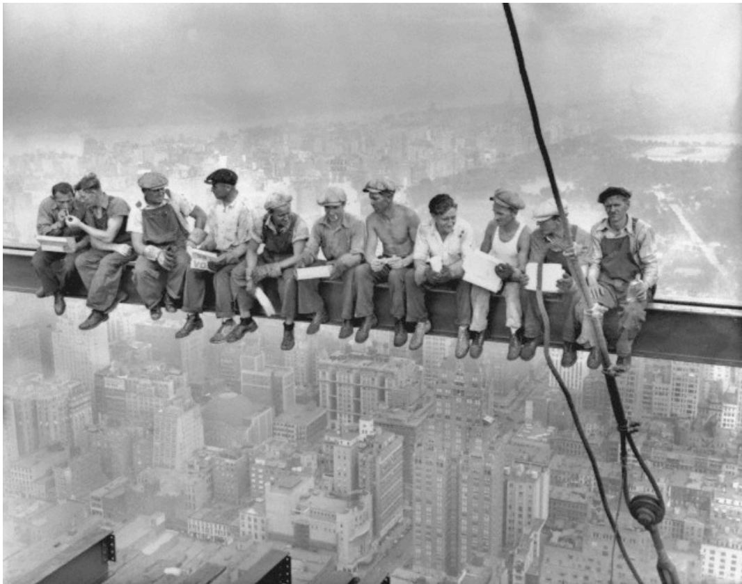
Kuva 1. Vielä 1930-luvulla ei putoamissuojaimia juuri tunnettu.
