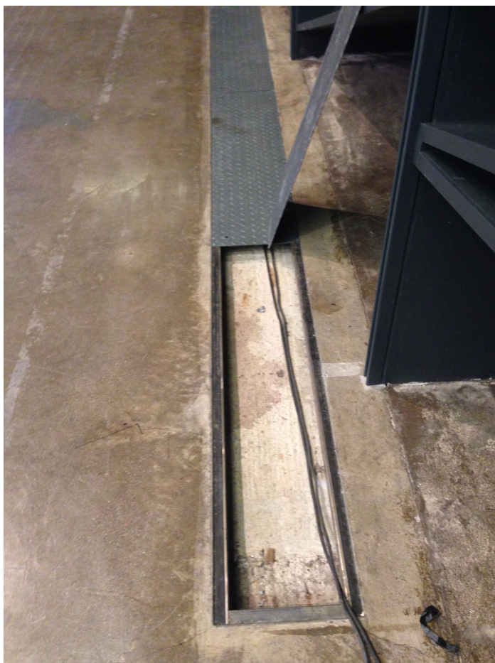
Kuva 8. Logomon kaapelikouru eli tekniikan yleiskielellä Rottametro.
