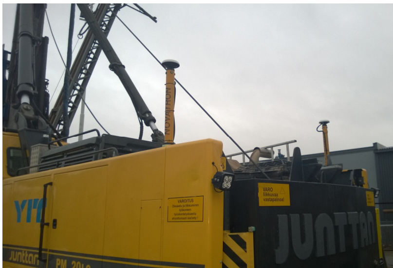
Kuva 12. Novatron-koneohjausjärjestelmän antennit on asennettu lyöntipaalutuskoneen takaosaan.
