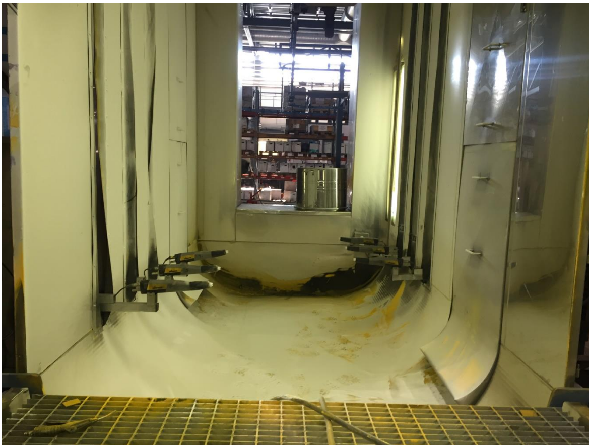
Kuvio 4. Maalaamon automaattikoppi ja suuttimet
