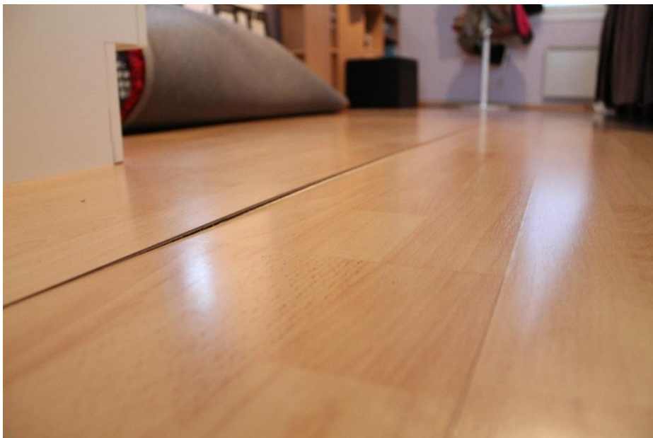
Kuva 34. Laminaatin sauma on auennut.
