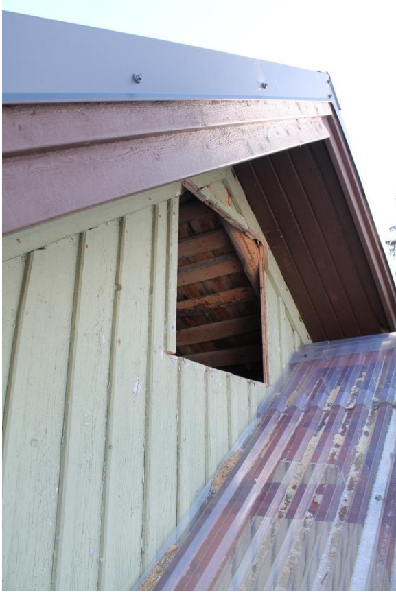
Kuva 28. Kulkuaukko yläpohjaan.
