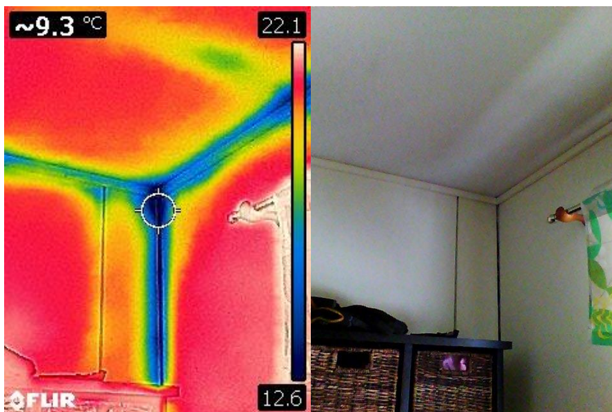
Kuva 14. Laajennusosan kaakkoinen ulkonurkka.
