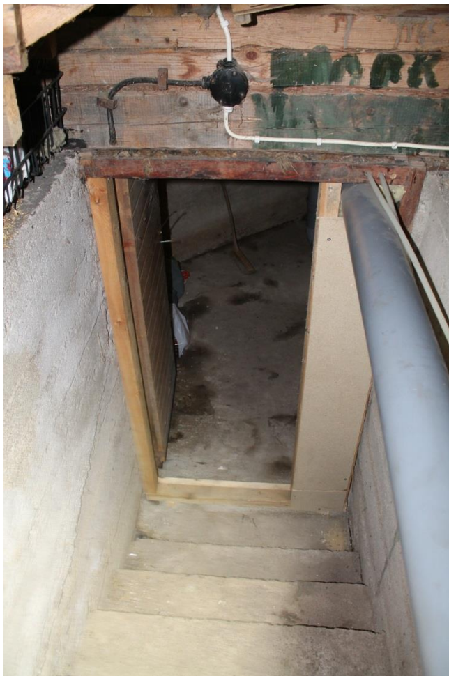
Kuva 11. Kellarin oviaukko ja keittiöön menevät vesi- ja viemäriputket.
