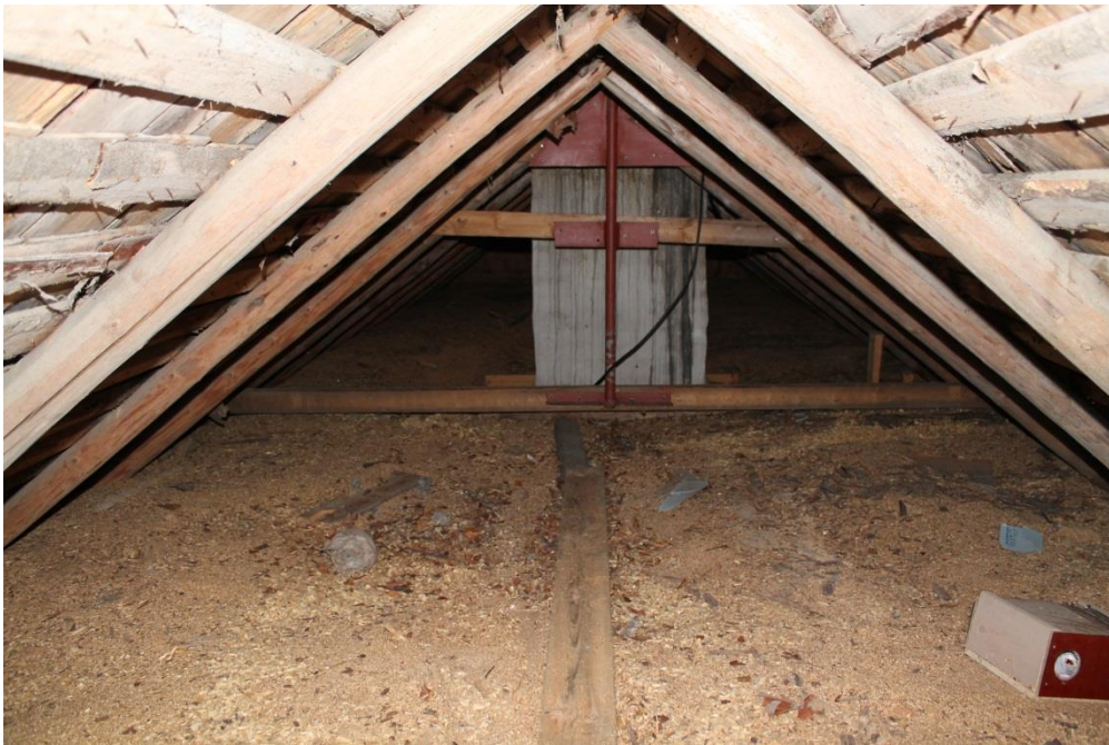
Kuva 29. Yläpohjan tuuletustila.
