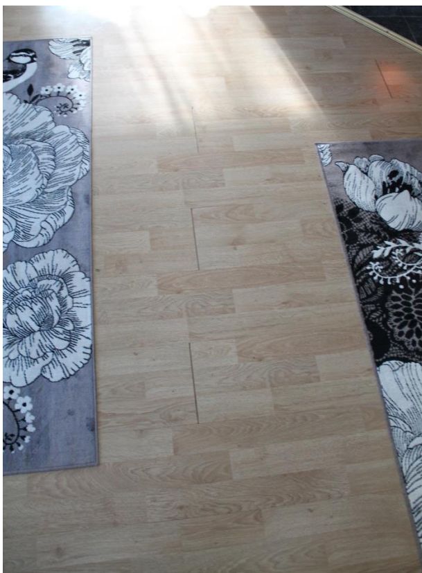
Kuva 35. Laminaatin päätysaumamat ovat auenneet.
