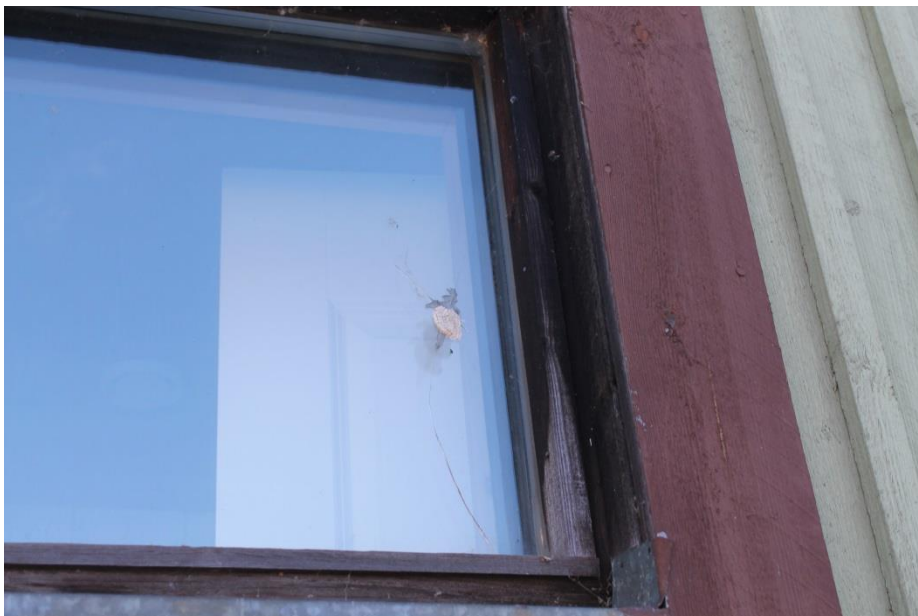
Kuva 25. Ikkunassa halkeama.
