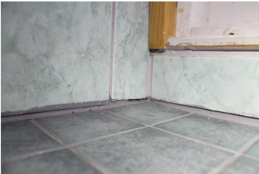
Kuva 37. Silikonit ovat revenneet.
