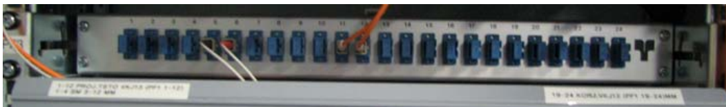
Kuva 10. Paneeli valokuitujakamosta.
