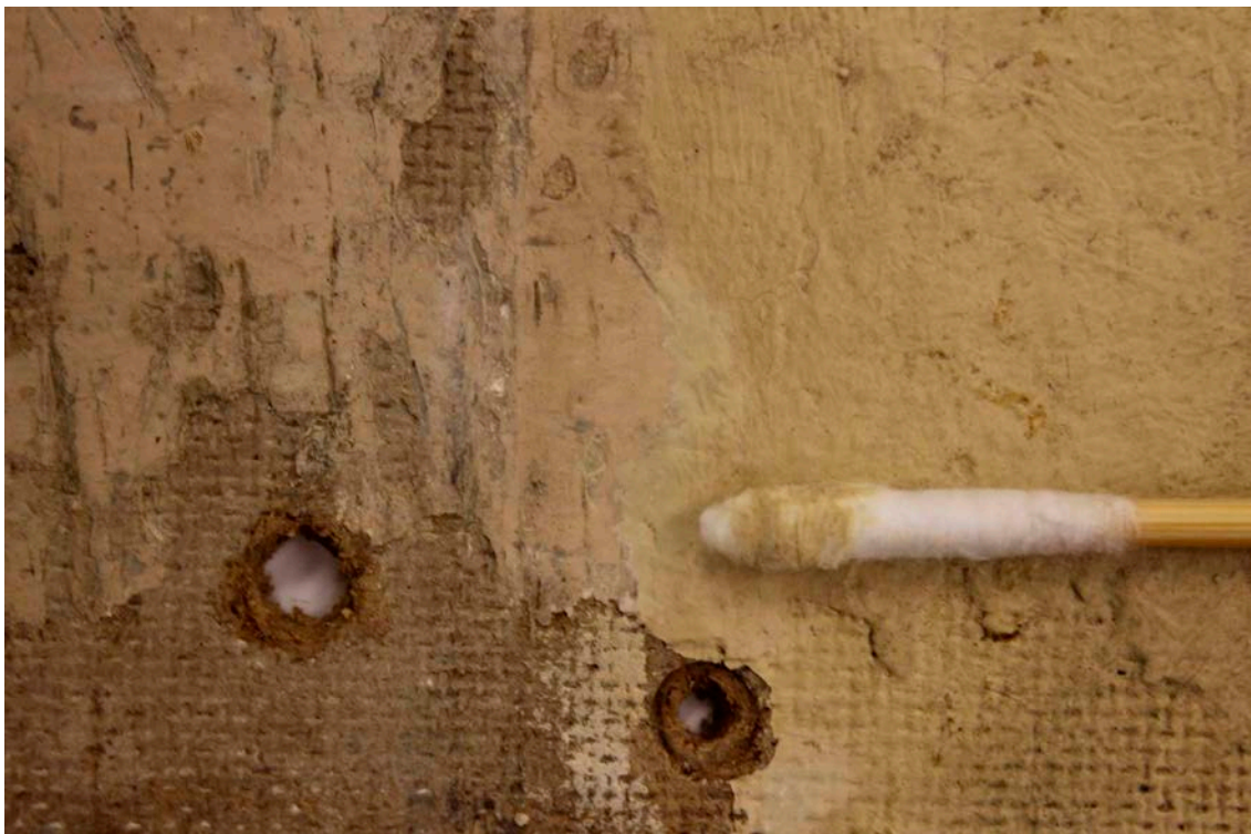
Kuva 32. Päällemaalauksen poistoa asetonilla.
