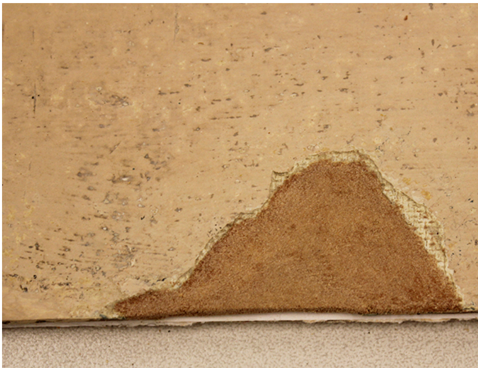
Kuva 38. Fenolimikropallo-sahajauho-täytemassa Plextol B 500 -sideaineessa kuitulevyn vaurio-alueelle.
