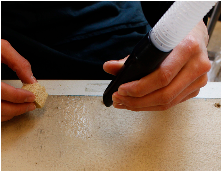
Kuva 33. Maalipinnan puhdistusta vesihöyryn avulla.
