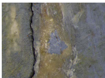
Kuva 23. Päällemaalauksen alla oleva tuntematon aine ja alkuperäinen maalipinta
