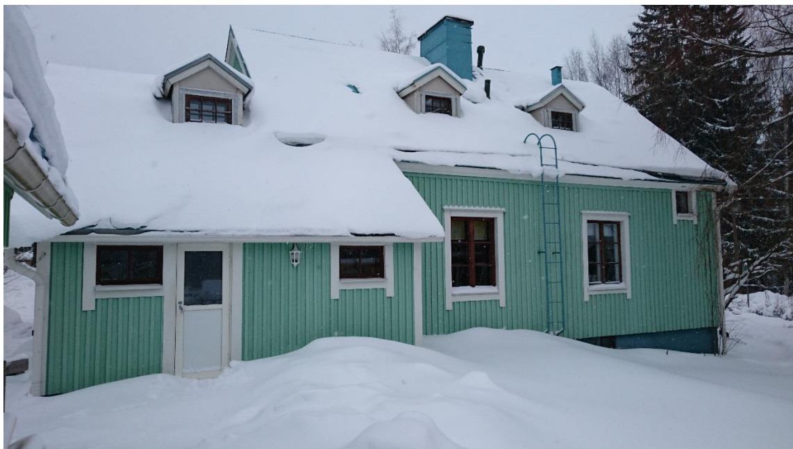
KUVA 9. Kohdetalo takapihalta (Takkinen 2016-02-22)
