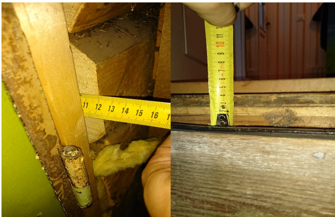
KUVA 14. Runkohirren sekä alapohjan lattialankun paksuus (Takkinen 2016-01-29)
