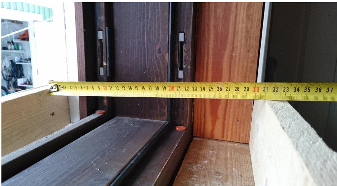
KUVA 15. Lisäsiiven seinän paksuus mitattuna (Takkinen 2016-02-11)
