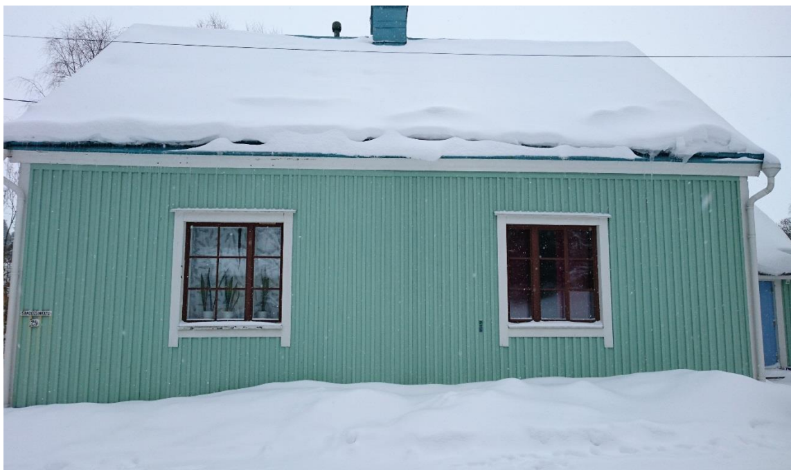
KUVA 7. Rakennus edestä. Paritalon jakava seinä kulkee savupiipun kohdalta (Takkinen 2016-02-22).
