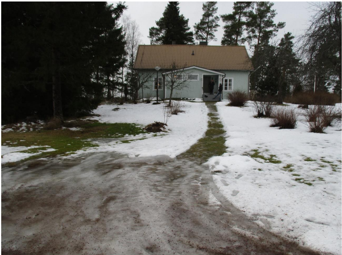
Kuva 3 Etupihalla eli idän puoleisella julkisivulla maanpinnan kallistukset ovat hyvät.
