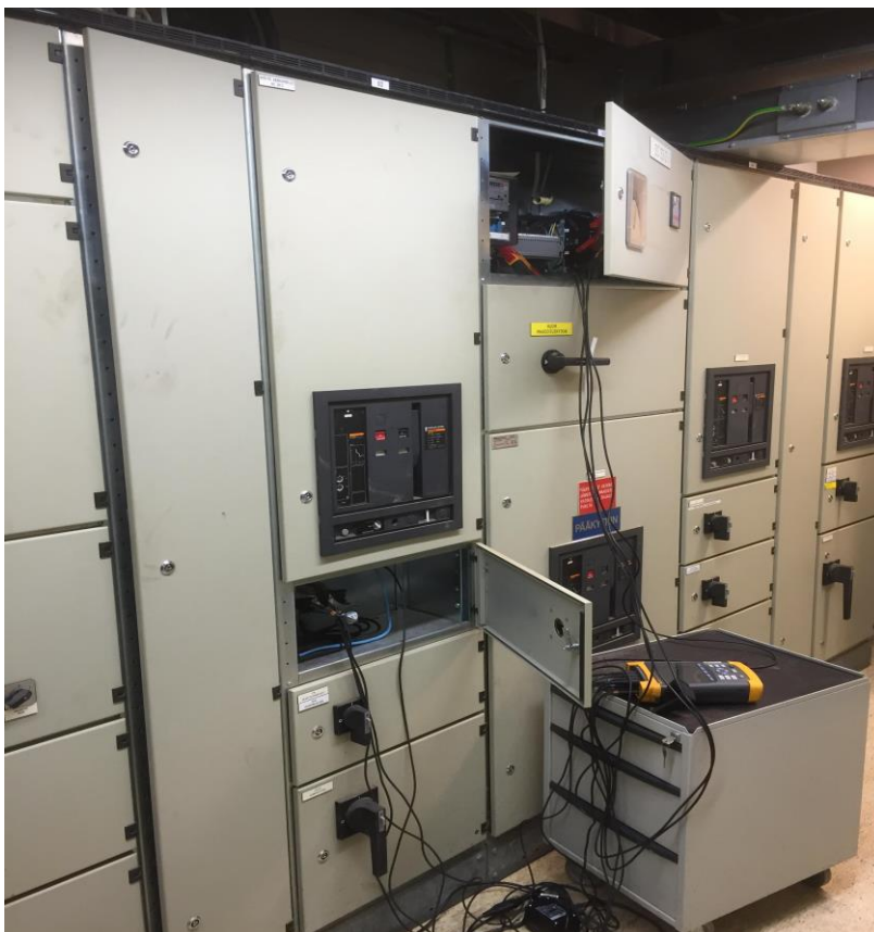
Kuva 3. Mittauskytkennät pääkeskuksessa.
