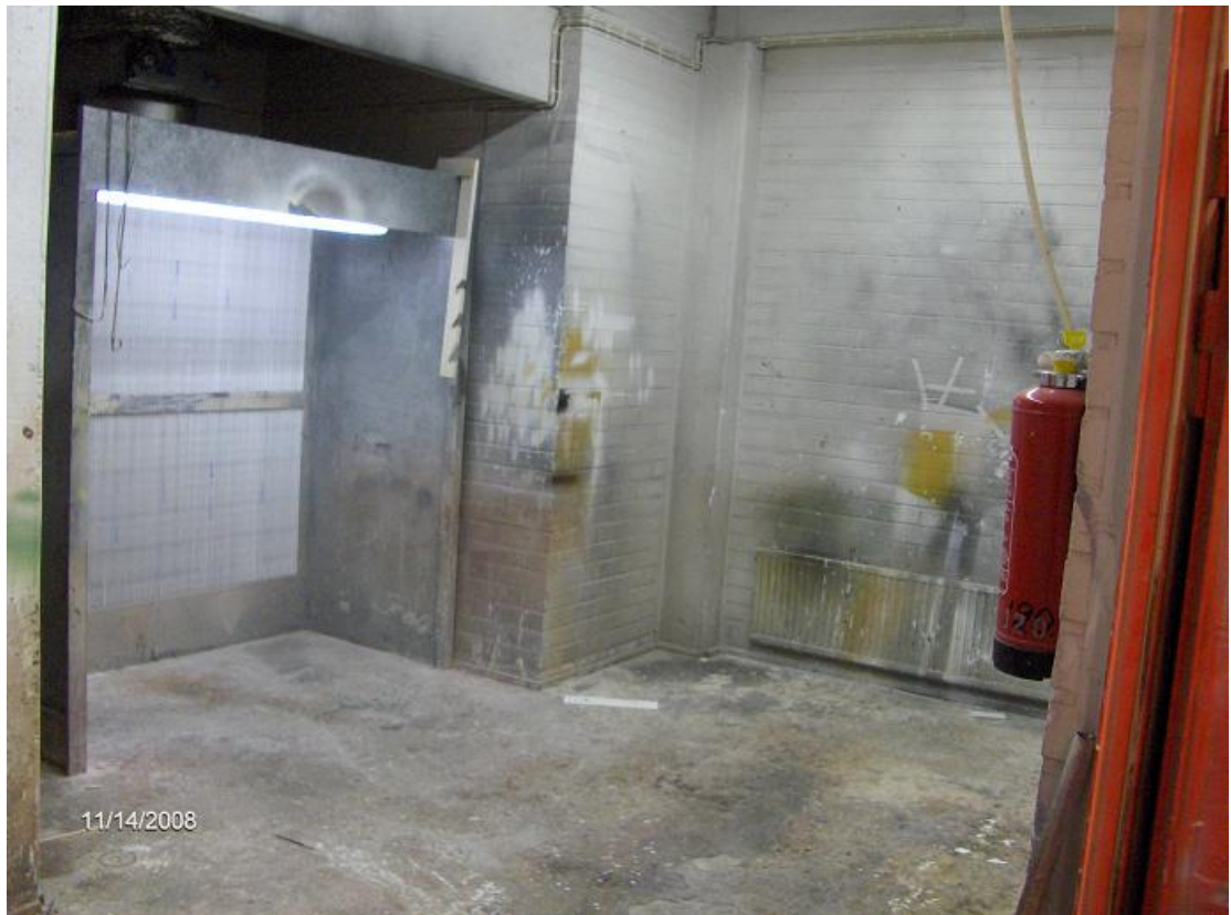
KUVIO 8. Vanha muovimatto on poistettu maalaamon lattiasta.
