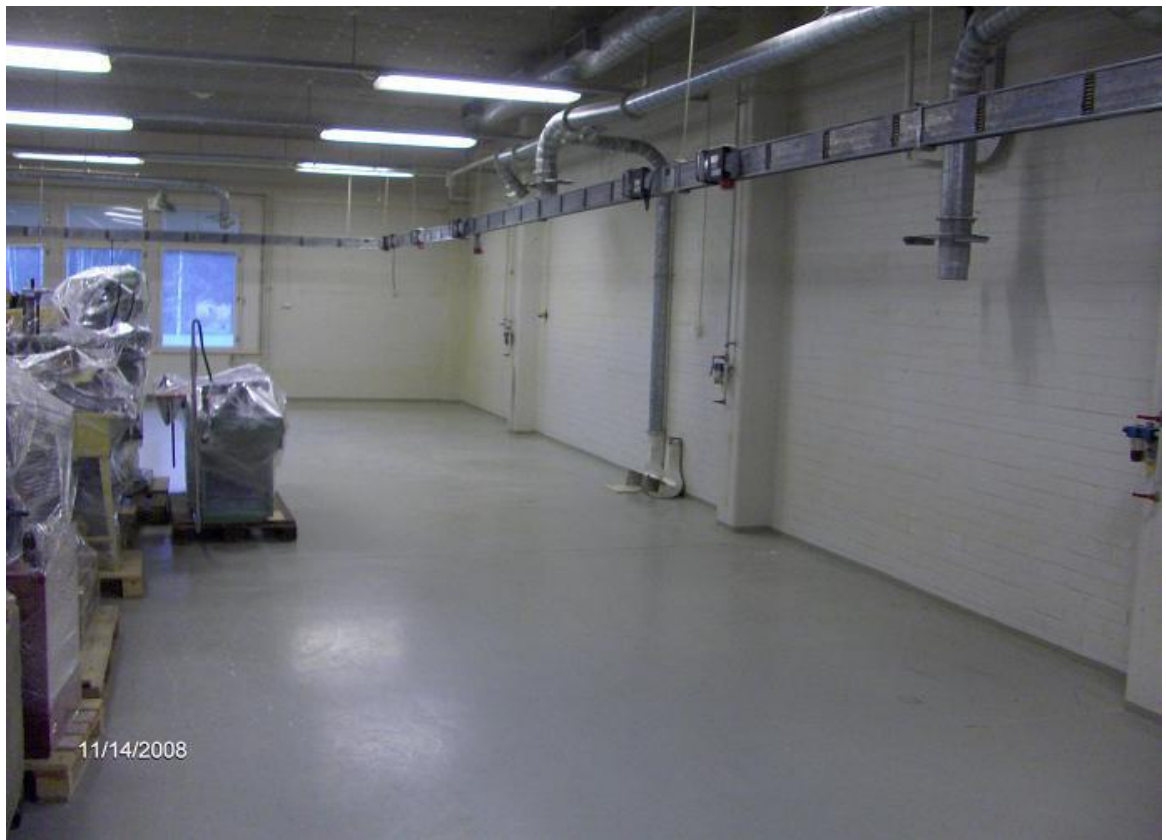
KUVIO 7. Valaistukselle, sähköistykselle ja purunpoistoputkistolle joudutaan tekemään tarvittavat muutokset.
