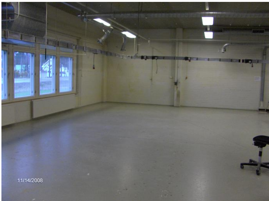
KUVIO 6. Puutyösali tyhjennettynä ennen korjausta
