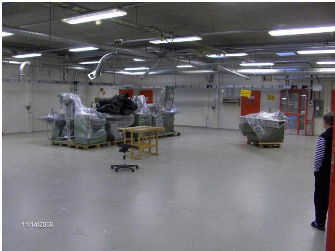
KUVIO 9. Puutyösalin isoimpien koneiden paketointi siirtolavoille mahdollisti niiden säilytyksen työmaalla korjauksen aikana.
