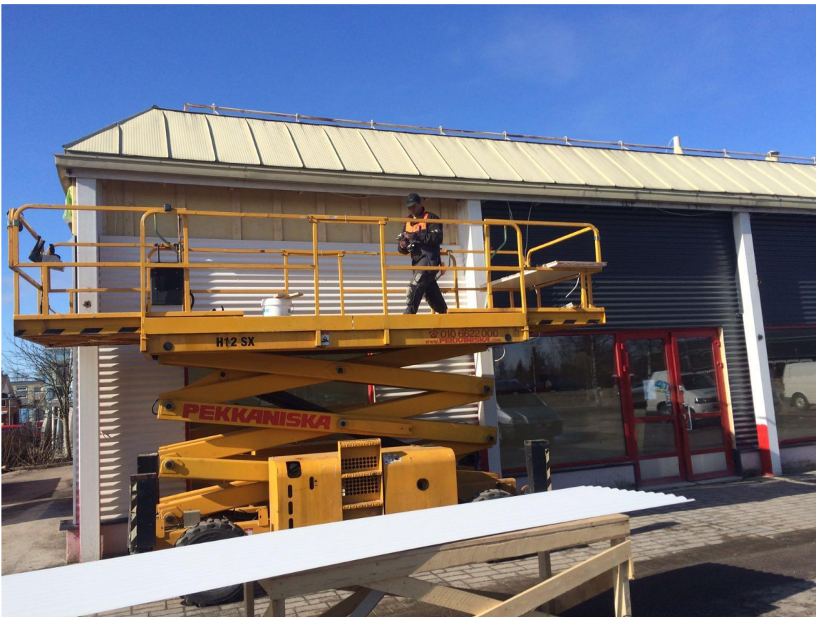
KUVA 5. Sähköliikkeen uudet tilat valmistuvat
