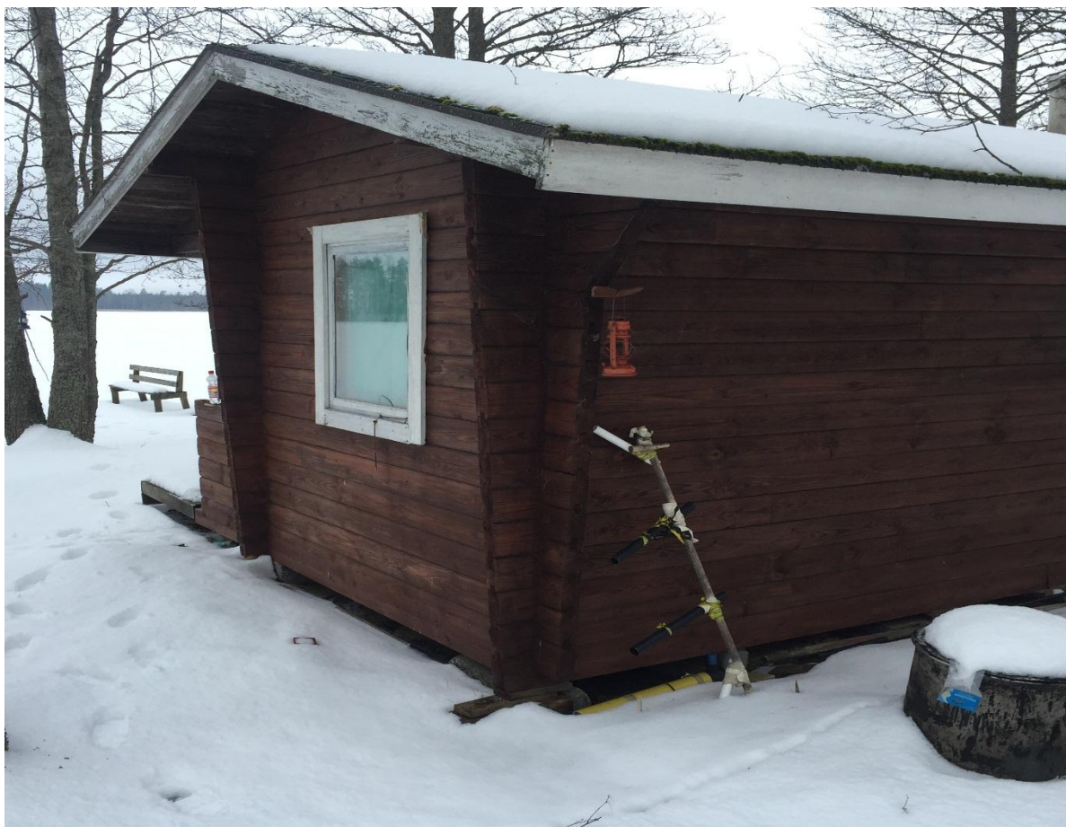
Kuva 4. Hirsirakenteinen Saunamökki (Pulkkinen 2016)
