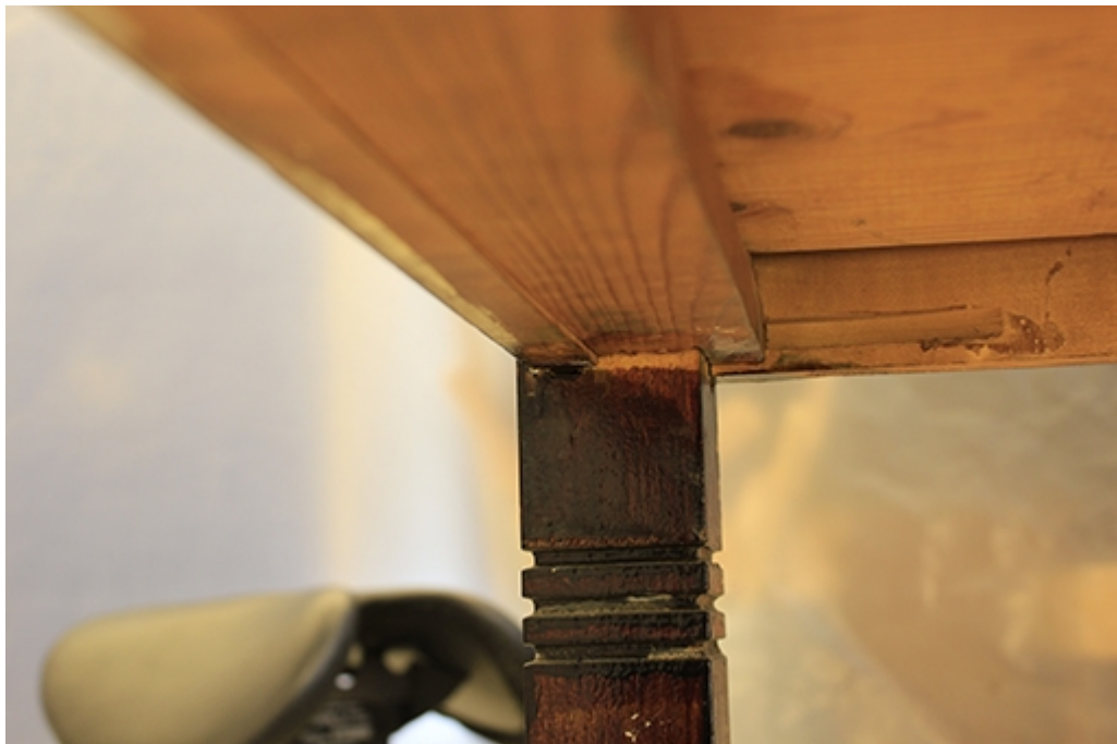
Kuvat 6–7. Sinkkaliitokset ja uraliitos.
