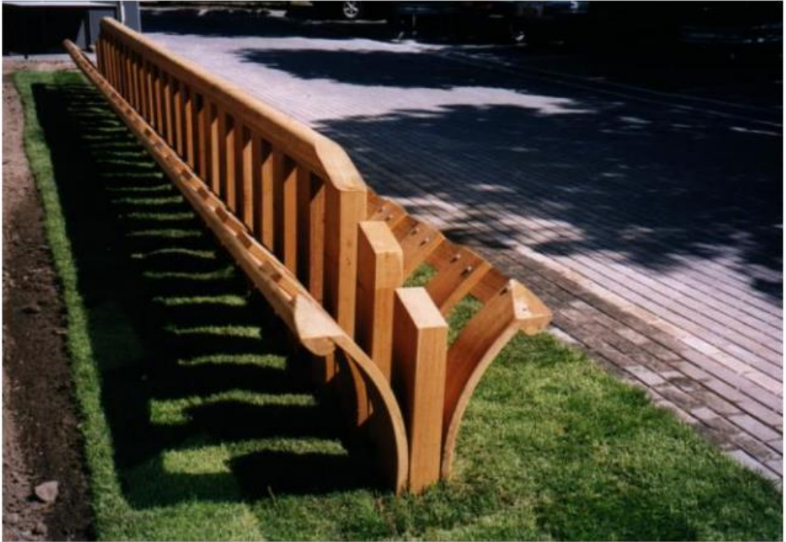
KUVA 10. Ensimmäinen H2 –törmäysluokan puinen tiekaide (van de Kuilen, J. W. G).
