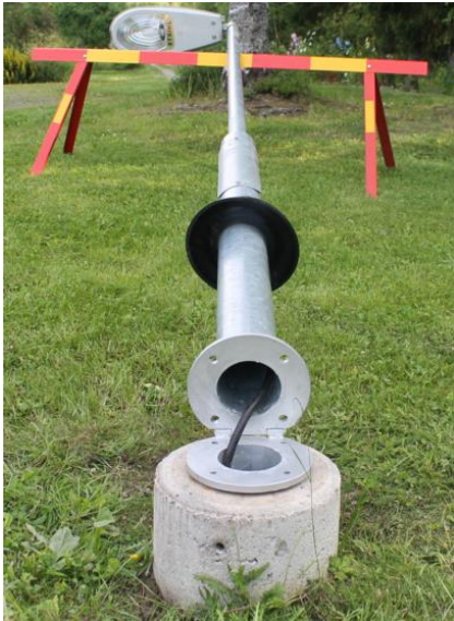
Kuva 6. Pylvään asennus jalustaan (Tehopylväs 2016)
