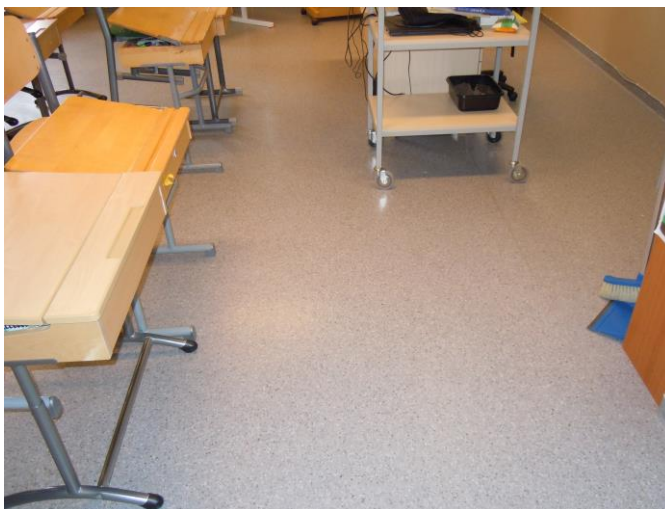
Kuva 19. 1-kerroksen luokkahuone, lattiassa on uusittu muovimatto.
