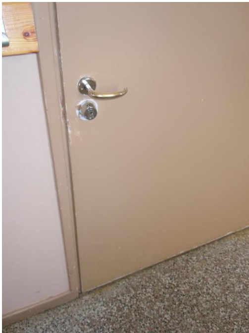
Kuva 16. 1-kerroksen luokkahuoneen sisäovi.
