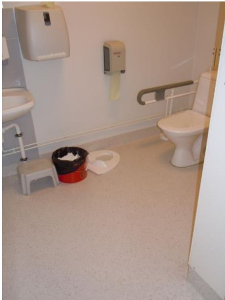
Kuva 21. 1-kerroksen uusittu wc.
