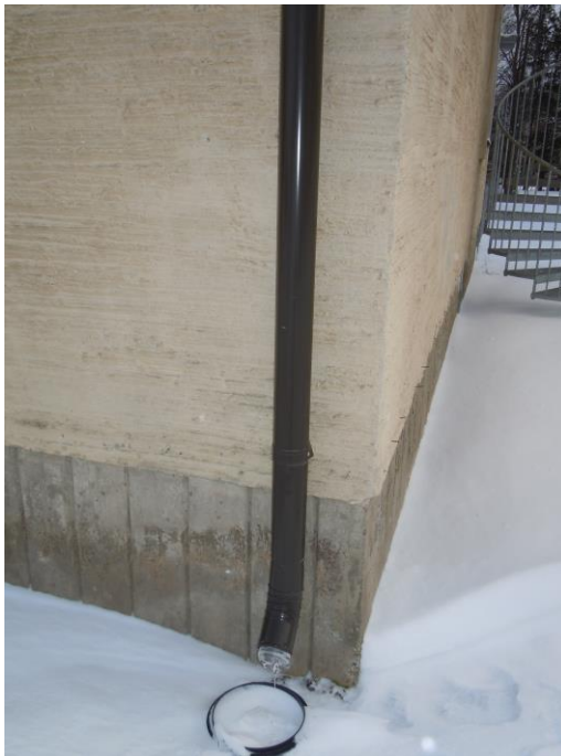
Kuva 8. Uusitut syöksytorvet.
