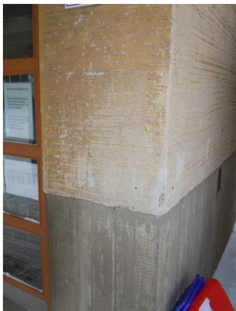
Kuva 5. Perusmuurin näkyvä osa.
