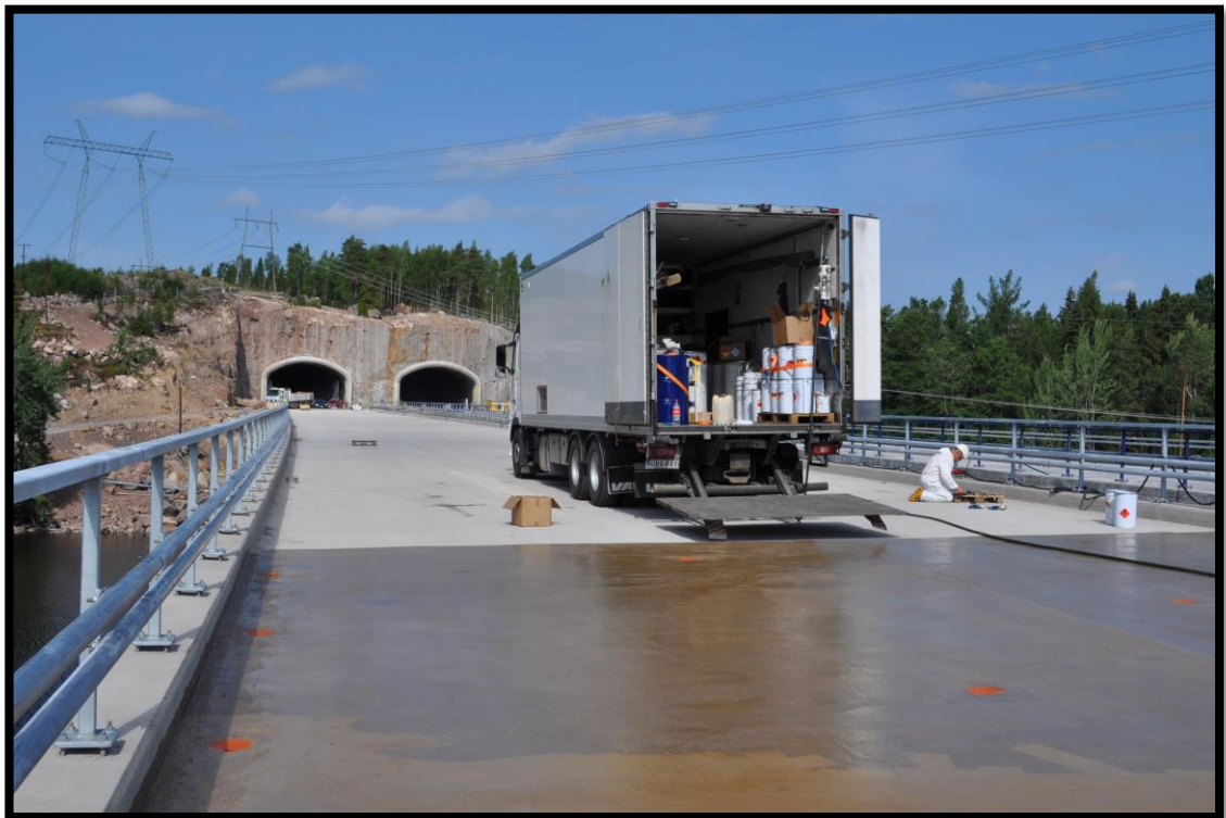
Kuva 26. Kuvassa etualalla tartunta-aine levitettynä
