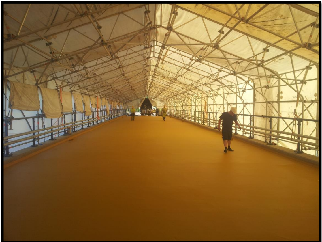
Kuva 1, Kuva sääsuojateltan sisältä
