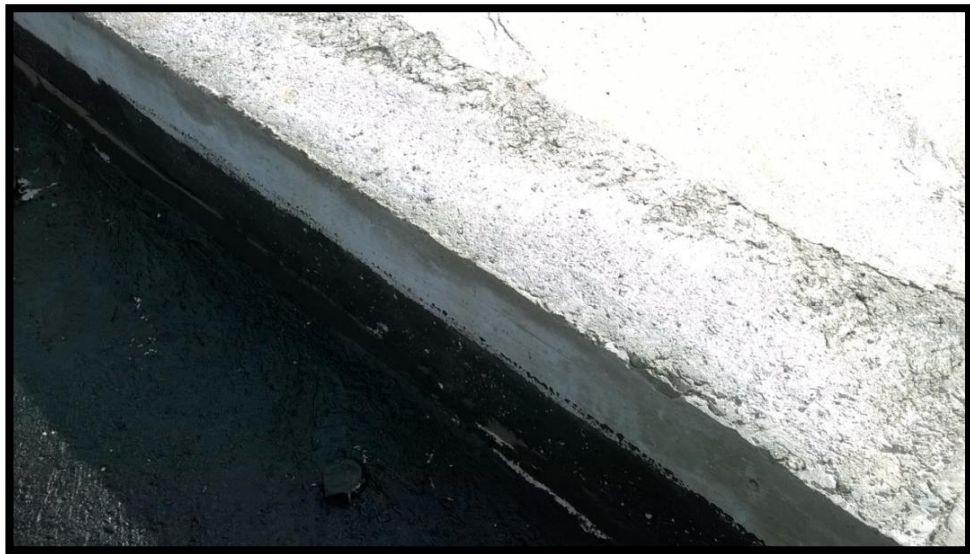
Kuva 11. Kuva viimeistelemättömästä kannen päädystä
