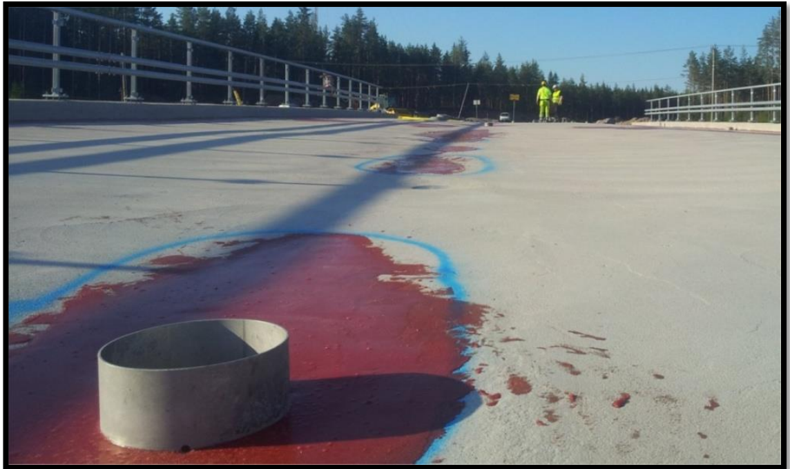
Kuva 15. Tiivistysepoksilla täytetty lammikoiden paikat pintavesiputken ympärillä
