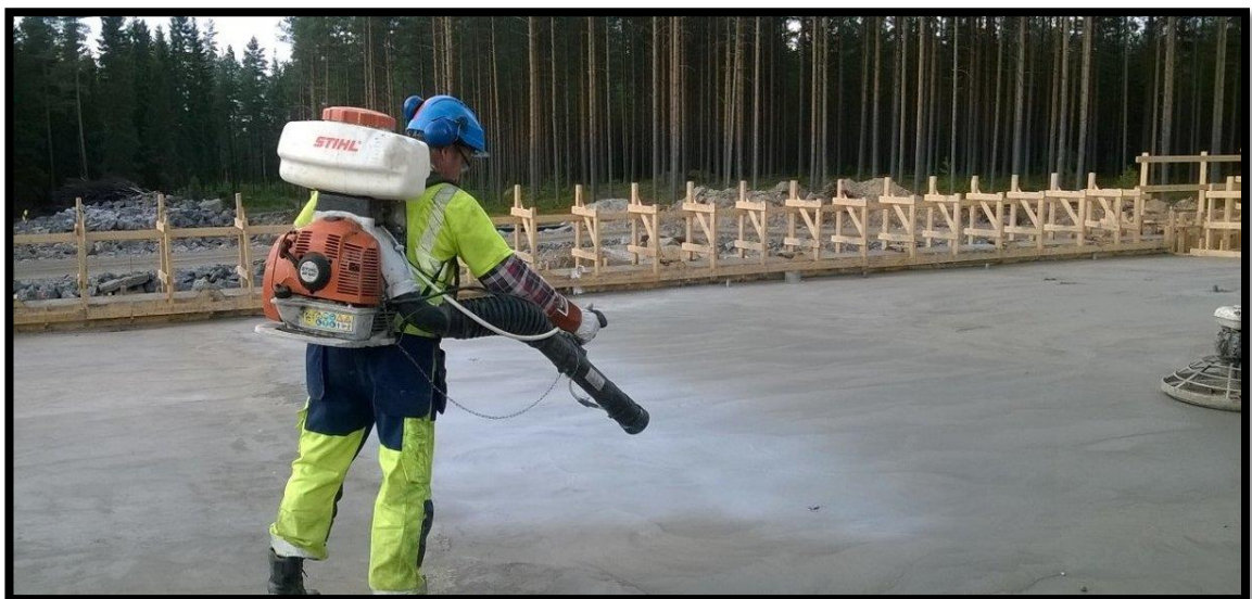
Kuva 8. Jälkihoitoaineen levitys koneellisesti
