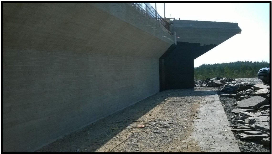
Kuva 5. Siipimuri bitumisivelty sisä ja -alapinnasta
