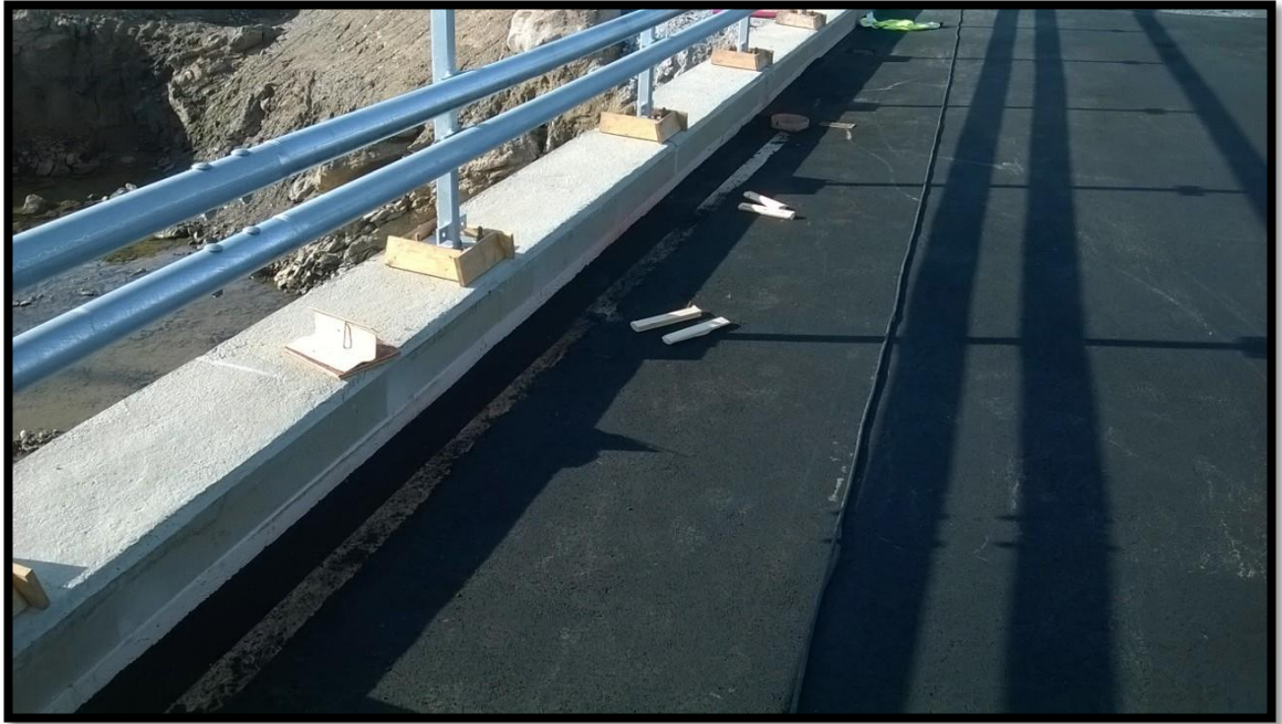
Kuva 6. Suoja-asfaltille jätetty varaus ja syöksytörven kaulus.
