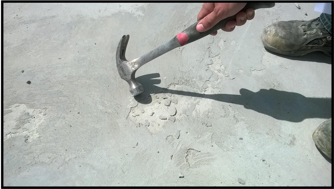
Kuva 13. Hierron yhteydessä erottunutta sementtiliimaa kannella
