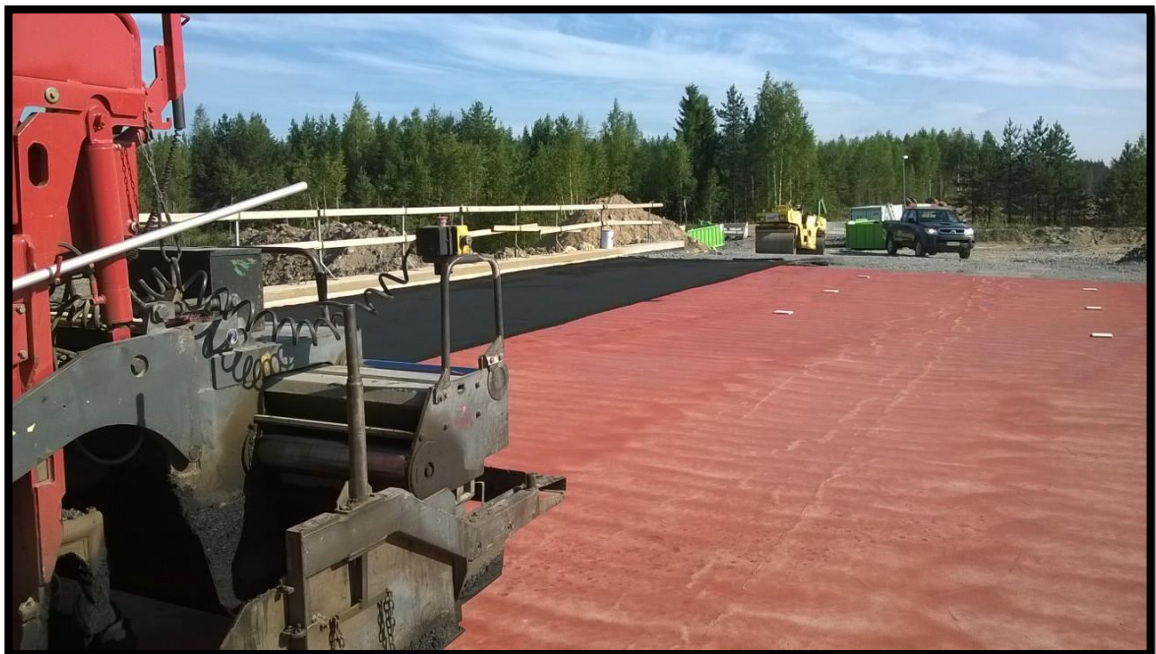
Kuva 28. Suoja-asfaltin levitys Bond Coatin päälle
