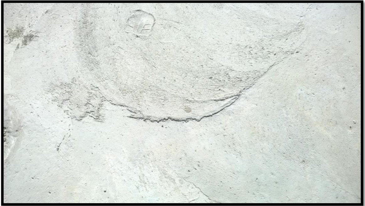
Kuva 12. Hiertimen jättämä reuna ja jalanjälki
