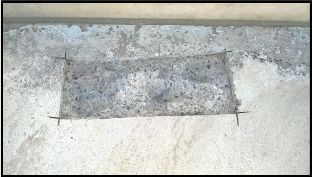
Kuva 9. Reunapalkkimuotin ura ja harvavalu
