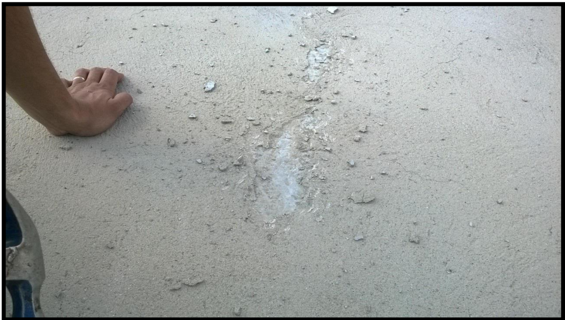
Kuva 14. Kannen pinnassa usean millimetrin huonolaatuinen sementtiliejukerros.
