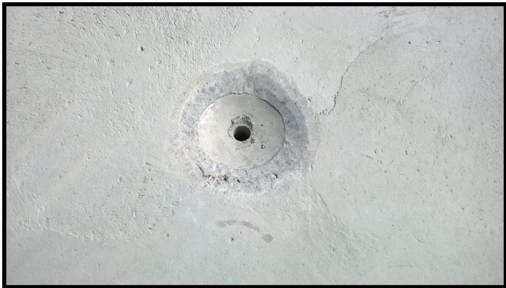
Kuva 10. Tippaputken reunojen pyöristys ennen karhennusta
