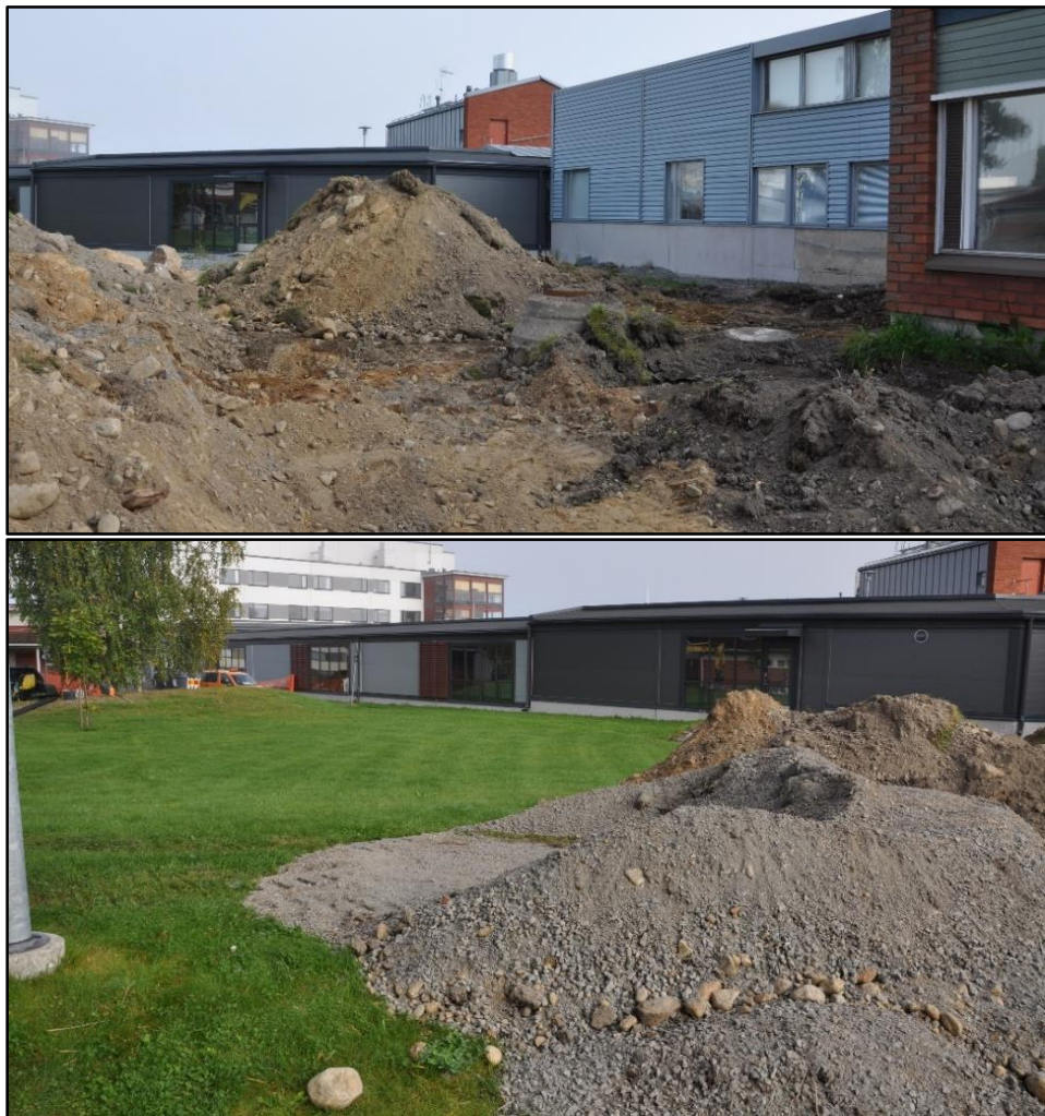
Kuva 19. Sisäpihan rakennusvaihe. (Noora Heikkonen syyskyy 2014.)
