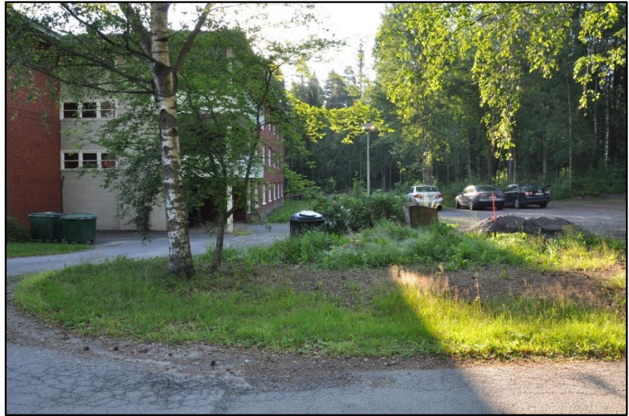
Kuva 16 Kerrostalopihan eteläpiha on kunnostamisen tarpeessa. (Noora Heikkonen heinäkuu 2014.)
