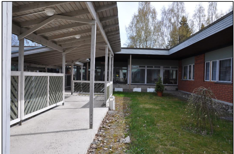
Kuva 4 Lohko 2 ennen suunnitelmien mukaisia rakennustöitä. (Noora Heikkonen toukokuu 2014.)
