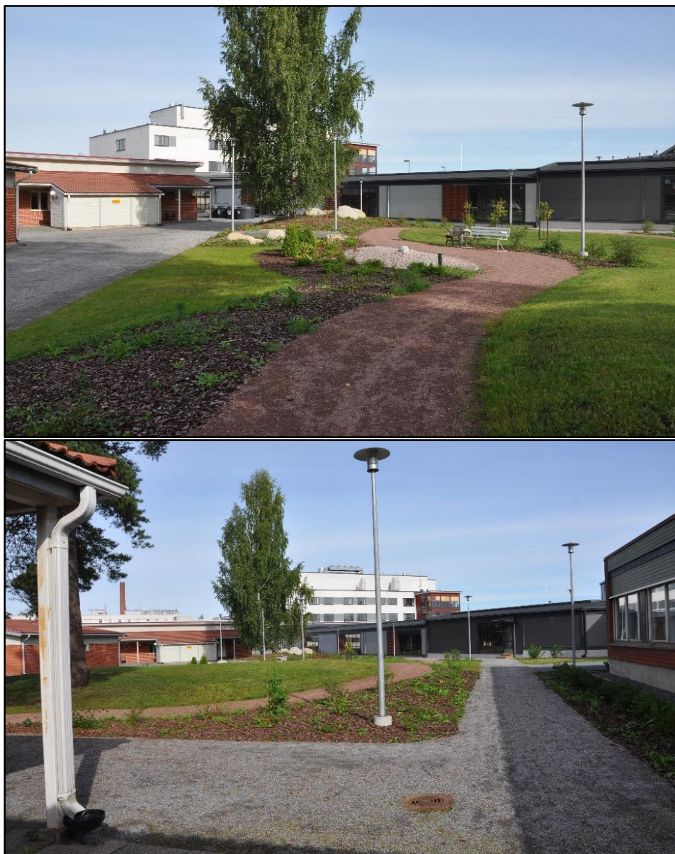
Kuva 22. Sisäpiha rakennustöiden jälkeen. (Noora Heikonen syyskuu 2015.)
