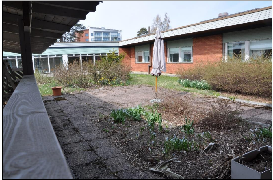
Kuva 5 Lohko 2 ennen suunnitelmien mukaisia rakennustöitä. (Noora Heikkonen toukokuu 2014.)
