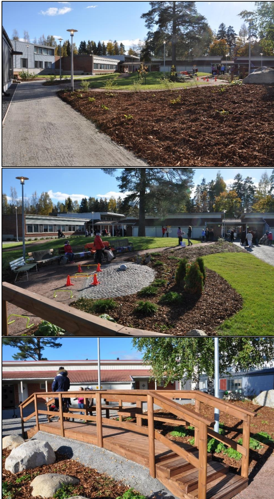
Kuva 23. Sisäpiha rakennustöiden jälkeen ja avajaiset. (Noora Heikkinen lokakuu 2015.)
