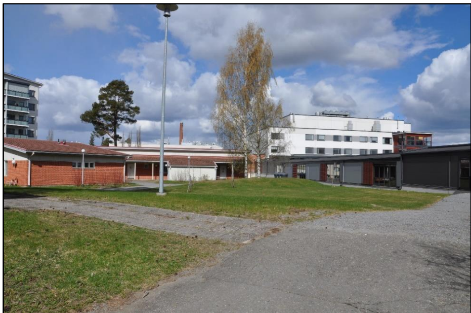
Kuva 4. Sisäpiha oli yleisilmeeltään siisti, mutta käyttöaste oli matala erilaisten toimintojen, kalusteiden ja varusteiden puuttumisen vuoksi. (Noora Heikkonen toukokuu 2014.)
