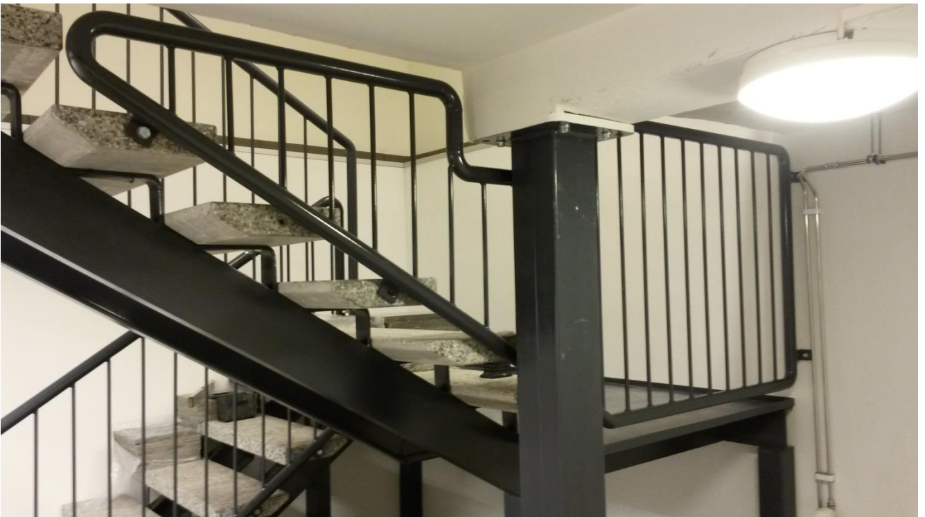
KUVA 2. Valmiit portaat (Pohjanmaan Metalli Oy 2016)
