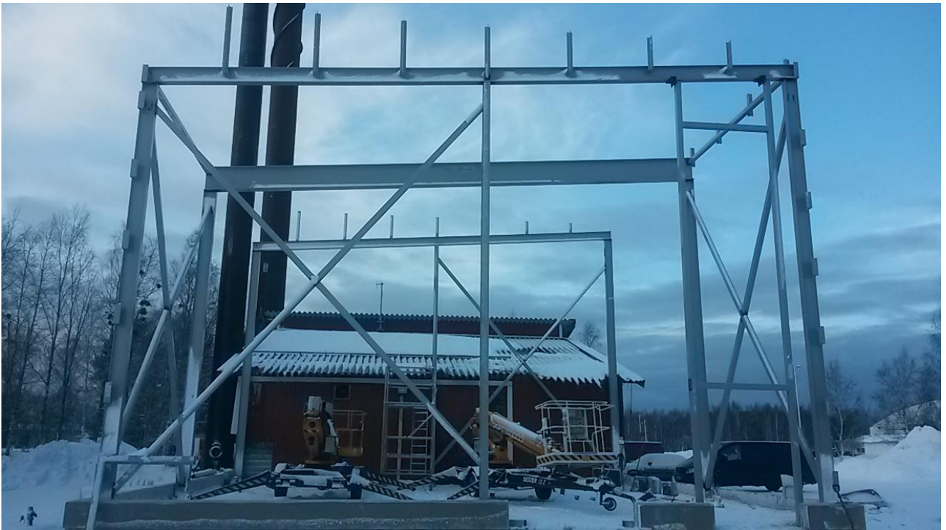
KUVA 3. Teräsrakenne (Pohjanmaan Metalli Oy 2016)
