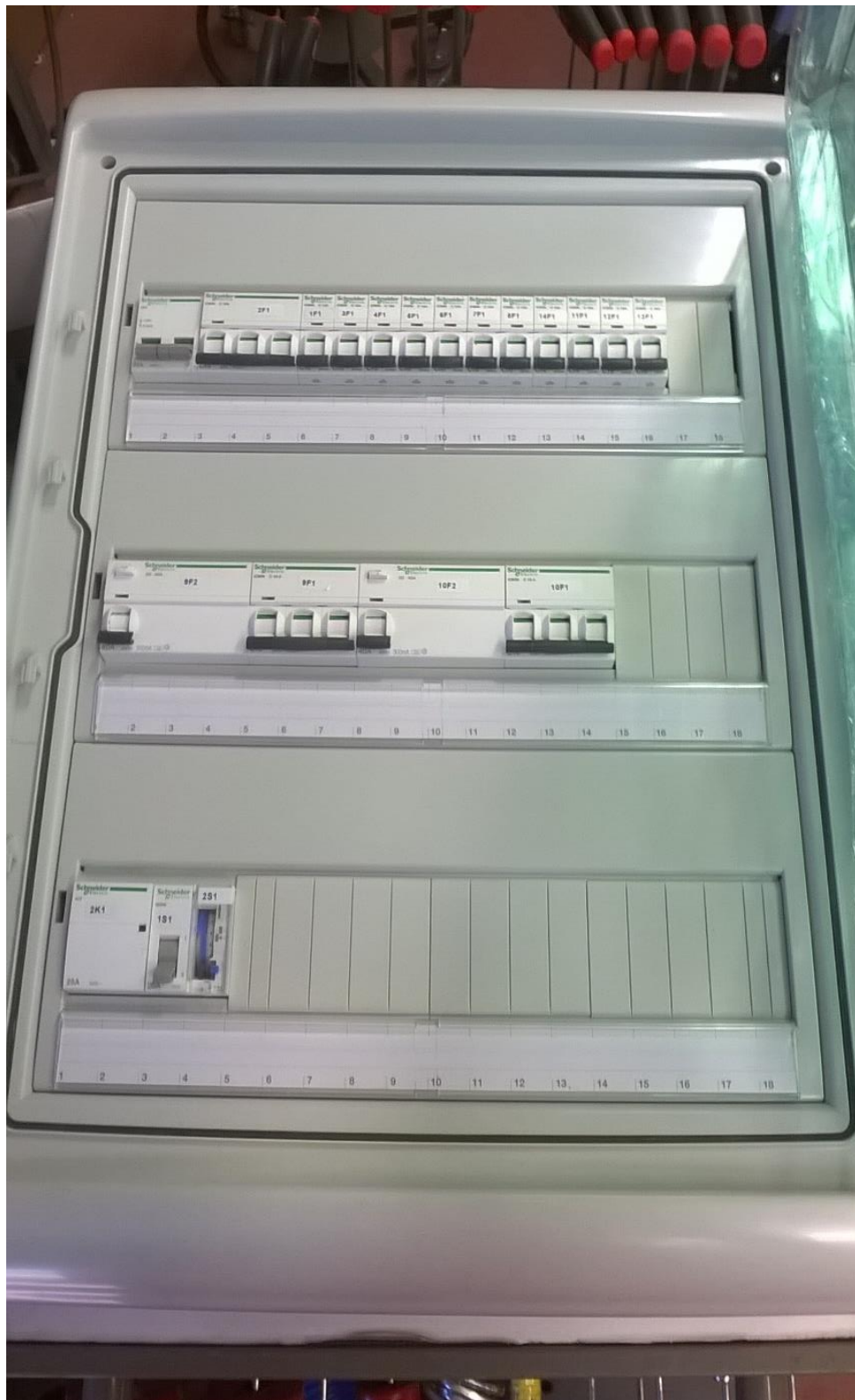
KUVA 4. Sekoitintason keskus valmiina
