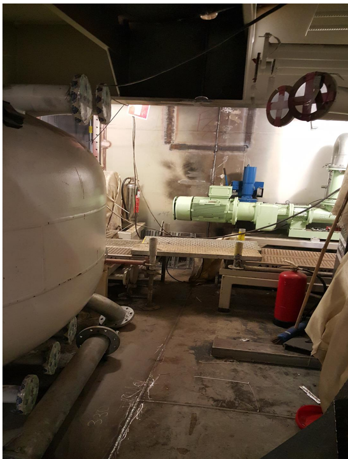
KUVA 23. Soviteputkien mittauspaikka lastipumpulla (Kuva: Riku Honkaniemi 2016)
