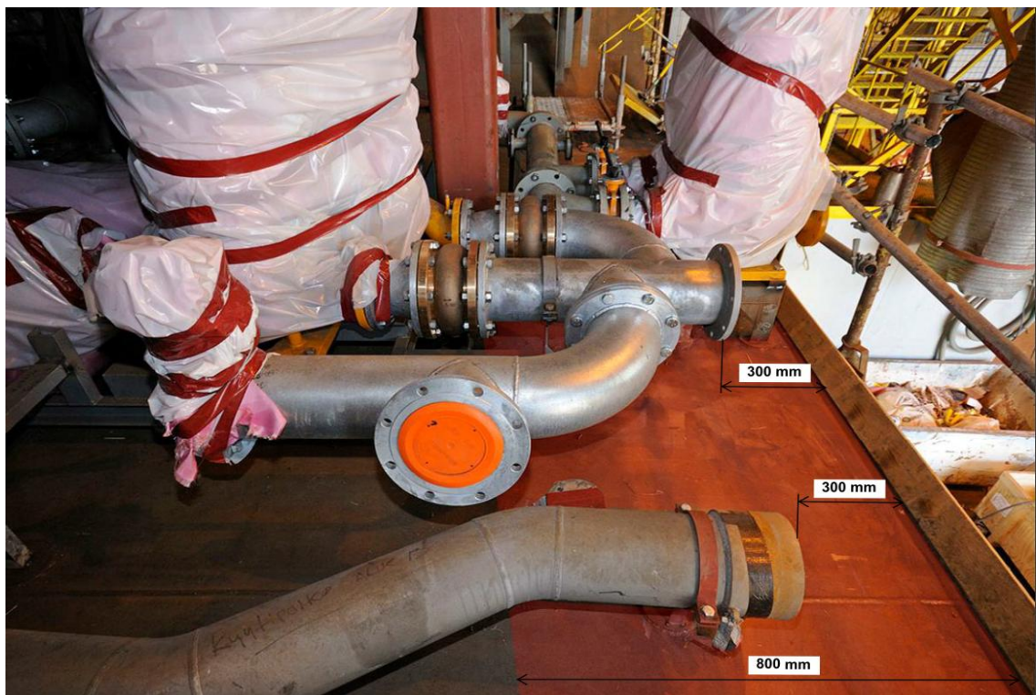
KUVA 6. Putken päät lohkorajalla. (Arctech Helsinki Shipyard Oy 2014)
