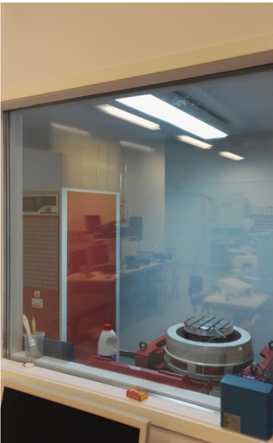
Kuva 23. Ikkuna äänieristetyssä huoneessa
