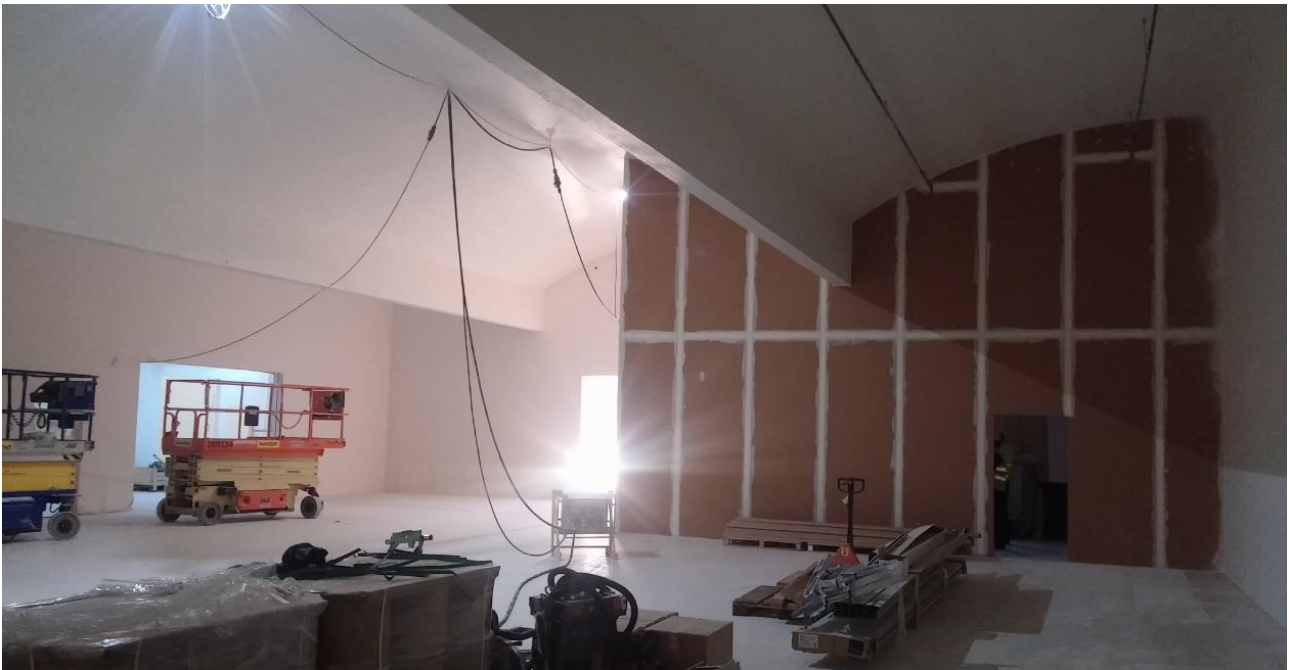
Kuva 18. Uudet Laboratorio tilat rakennus vaiheessa.
