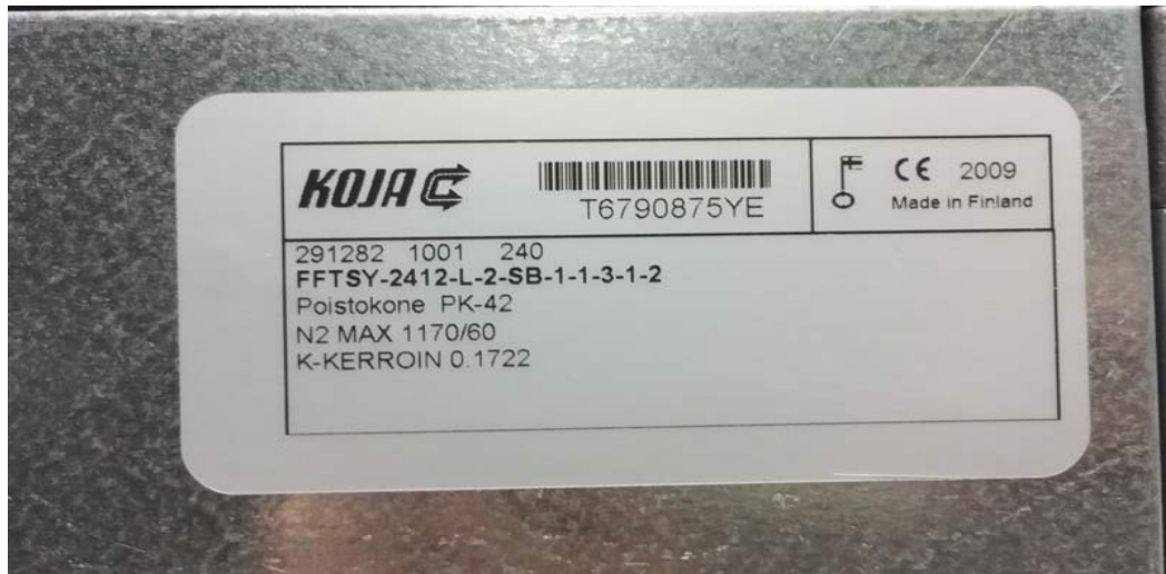
KUVA 14. Puhaltimen tyyppikilpi, PK42
