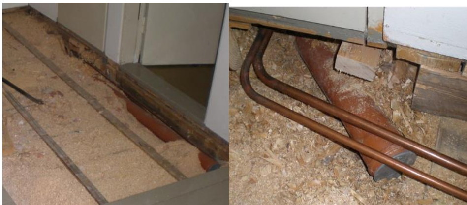
Kuvat 3 ja 4. 2010 tehdyn 2 kerroksen remontin yhteydessä korjattu notkuva lattia. Samalla lyhennetty vesi ja viemäriputket vanhan keittiön kohdalla.
