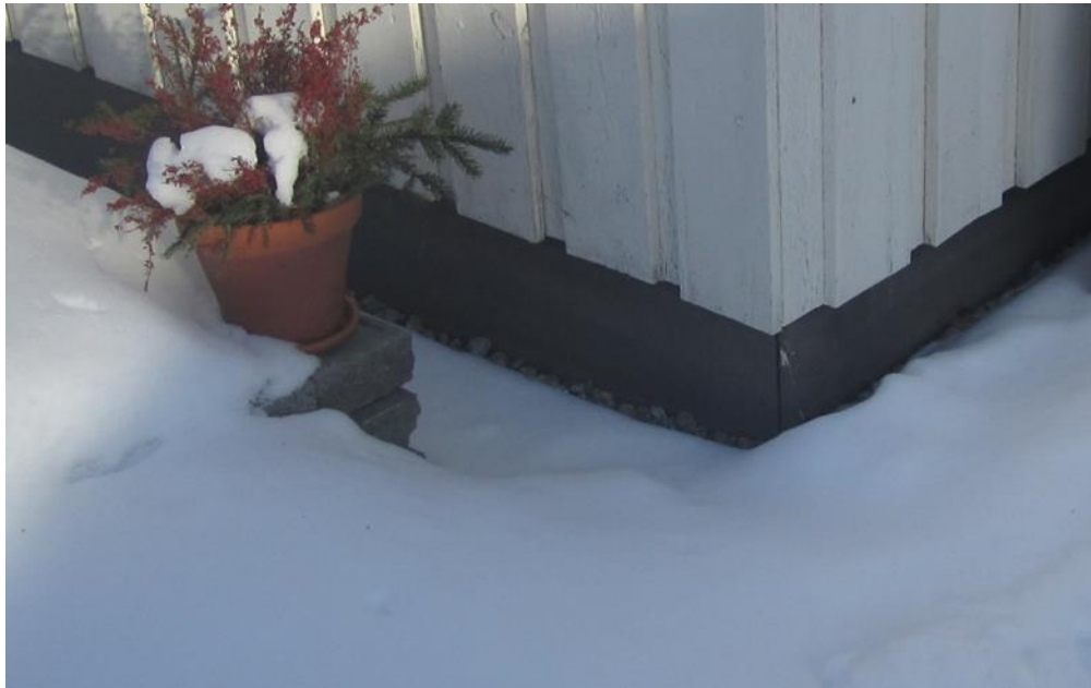
Kuva 1. Lujalevy sokkelin eristeen päällä.
