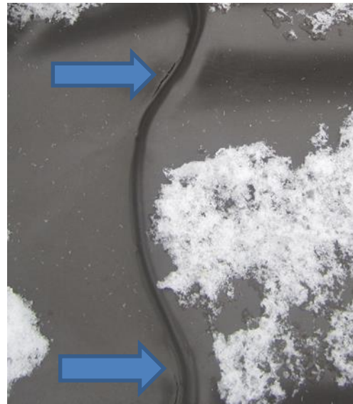
Kuva 10. Tarkastusluukun halkeamat.
