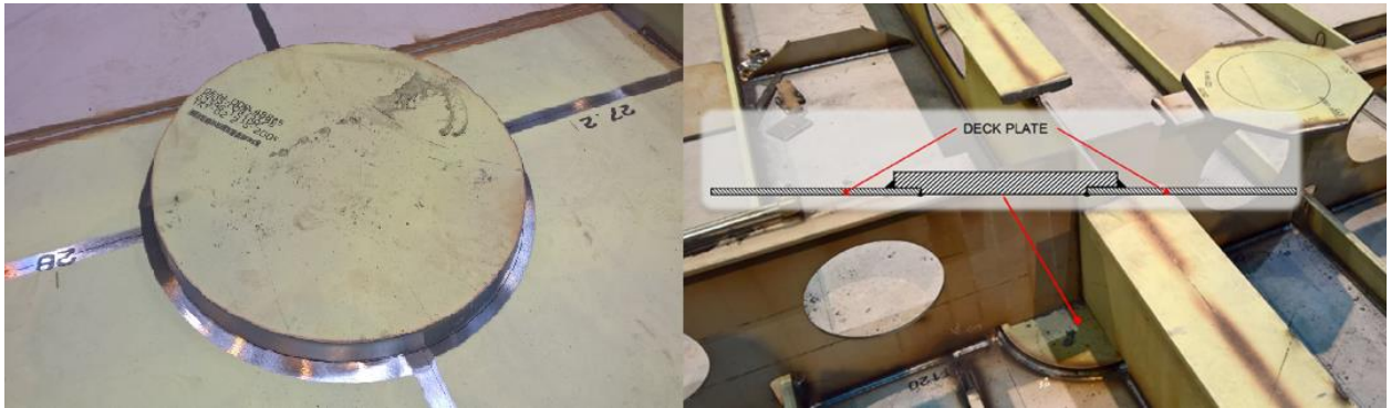
Kuva 7. Pylvään aluslevyn asentaminen laattaan.
