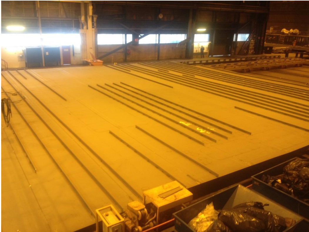
Kuva 1. Valmis laatta siirrettäväksi lohkonrakennushalliin.
