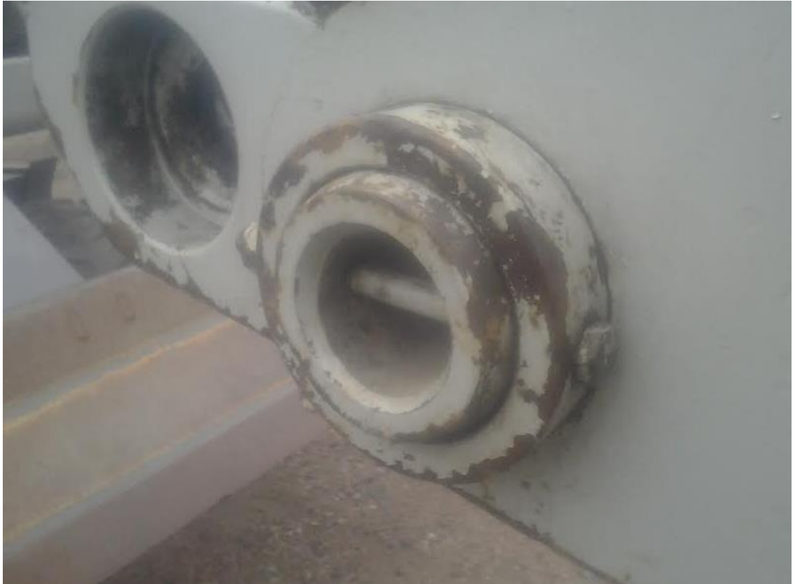
Kuva 11 Kiinnikkeen niveltapin kiinnitys
