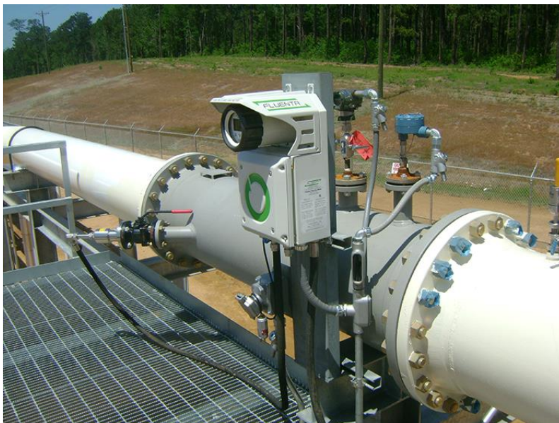
Kuva 9. Soihputkiston ultraäänivirtausmittaus [10]
