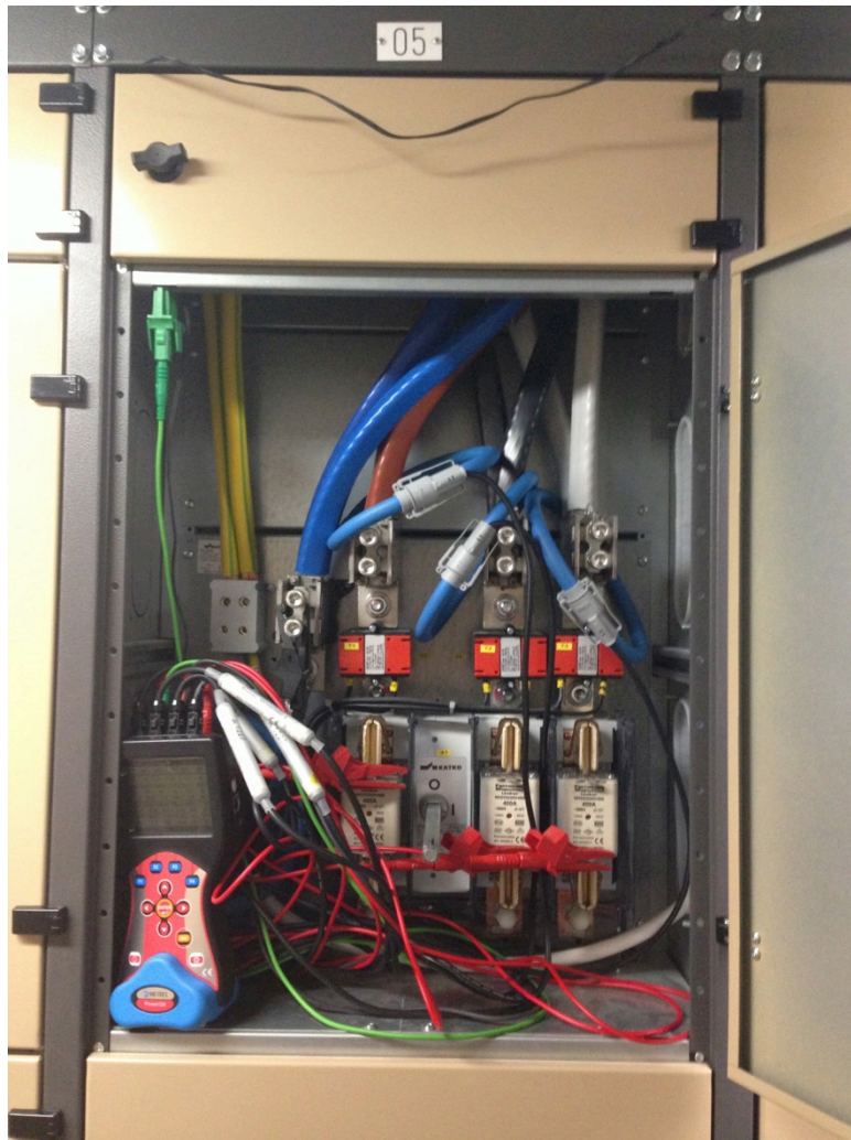
KUVA 2. Mittauskytkentä pääkeskuksella
