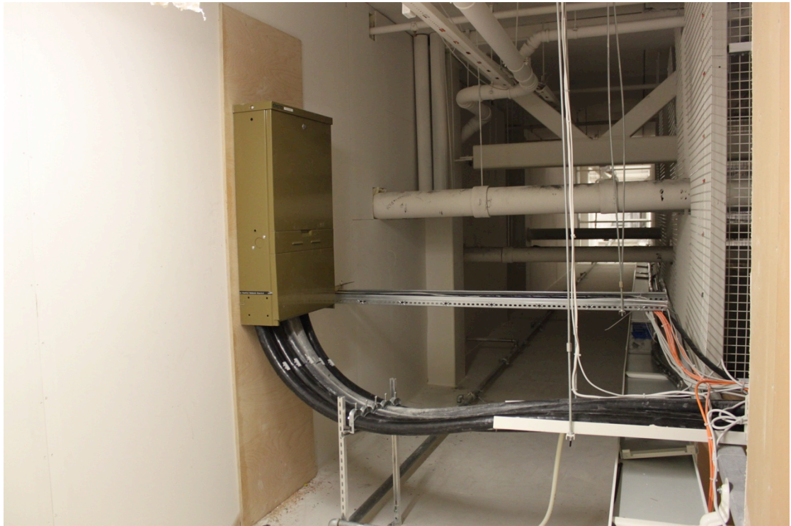
KUVA 6. Uusi katujakokaappi huoltotasolla
