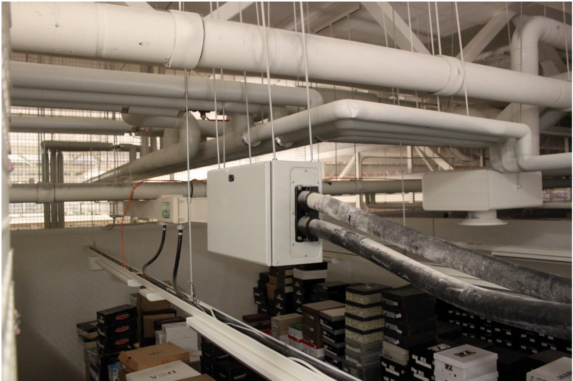
KUVA 5. Virtakiskon alkuperäinen syöttörasia
