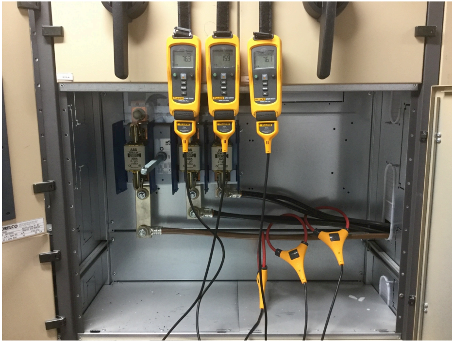
KUVA 12. Kompensoinnin lähdön virtamittaus
