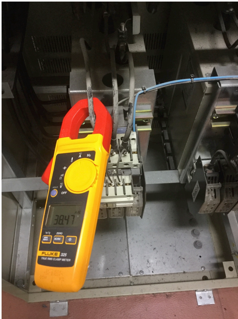
KUVA 11. Virran mittaus kondensaattorilta
