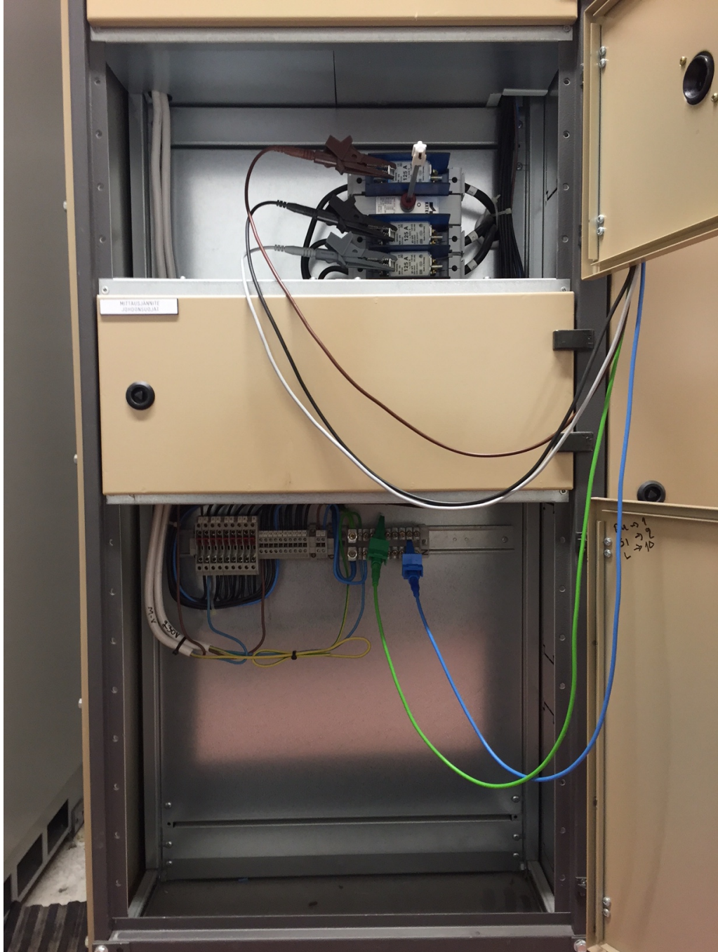
KUVA 15. Analysaattorin jännitemittaukset
